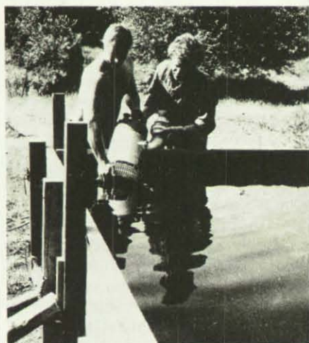
Aus dem selbsterrichteten Behälter förderte die 1000-l-Tauchpumpe des I-Zuges das Wasser.
