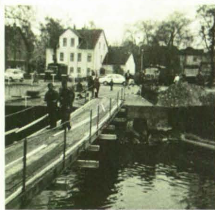
Der OV Northeim baute eine Leichtmetallbrücke über den Rhume-Kanal als Fußgängerüberweg.
