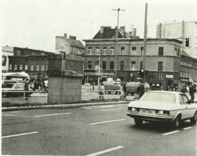
Auf dem Mittelstreifen der Fahrbahn Badstraße in Berlin-Wedding, direkt über dem U-Bahnhof, stehen zwei Zuluft- bzw. Abluftbauwerke, die der Belüftung der Mehrweckanlage dienen.
