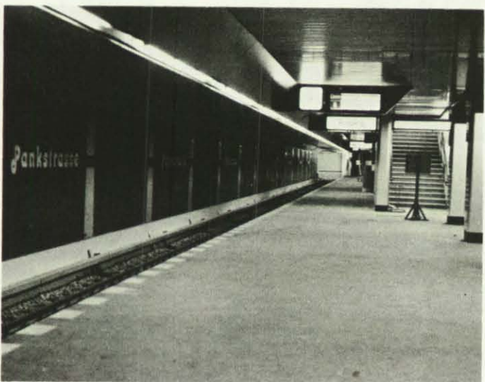
Der noch nicht in Betrieb genommene U-Bahnhof während der Funktionsprüfung durch den TÜV: Im Hintergrund ist der Abschluß des Tunnelbereichs durch ein Hub-Schwenktor zu erkennen, seitlich in den Wänden – in Höhe der Beschriftung – die Lüftungsschlitze, über die in eingefahrene U-Bahnzüge (als Liegeräume) Luft geblasen wird.
