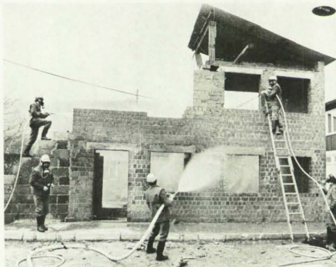
Löschangriff mit einem C- und zwei D-Strahlrohren.
