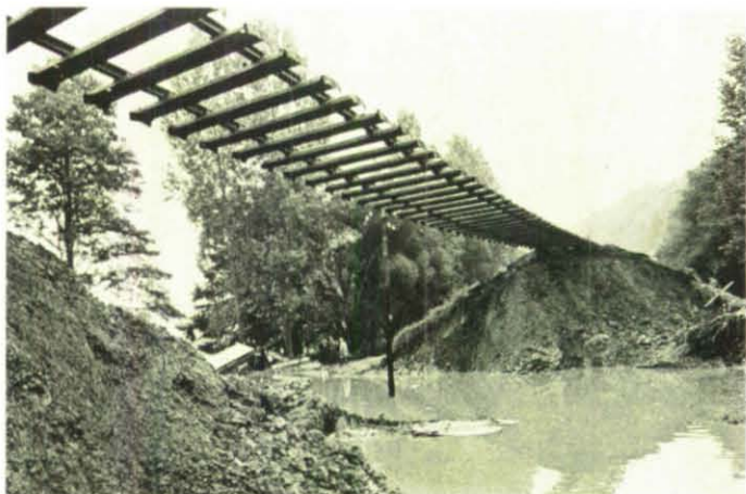
Auf einer Breite von 20 Metern wurde der Bahndamm der Bahnlinie Hersfeld-Schwalmstadt bei der Flutkatastrophe im Ibratal fortgespült.
