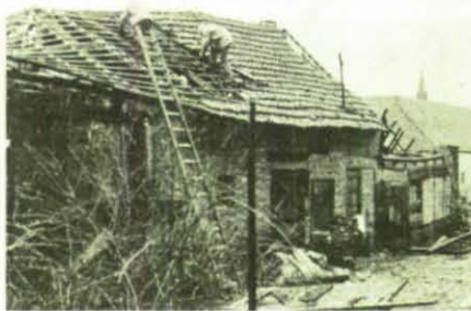
Helfer des OV Theley decken das Dach des baufälligen Anwesens ab.
