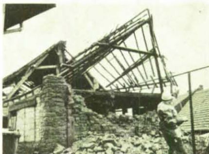
Dachstuhl und Mauerwerk werden mit Hilfe von Greifzügen ingerissen.
