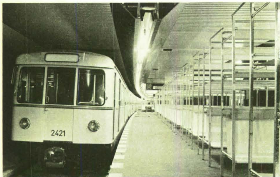
Der U-Bahnhof Pankstraße als Schutzraum. Eingefahrene Züge dienen als Liegeräume, daneben auf dem Bahnsteig Sitz-Liege-Kombinationen.
