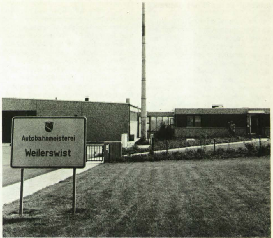
Im Bereich der Autobahnmeisterei Weilerswist wurde die praktische Erprobung der neuen Meldetechnik durchgeführt.
