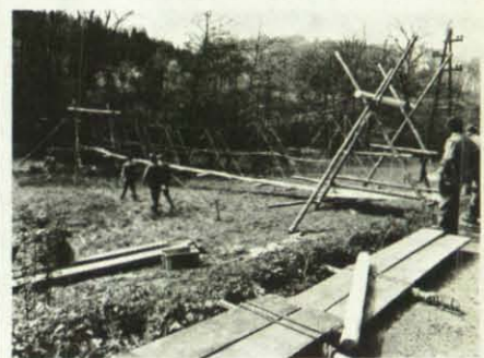
Ein 35 m langer Hängesteg wurde vom OV Bochum erstmalig errichtet.
