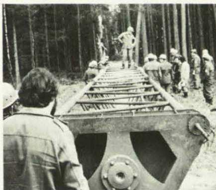
Genau in die vorbereitete Schneise fiel der 113 Meter hohe Gittermast.
