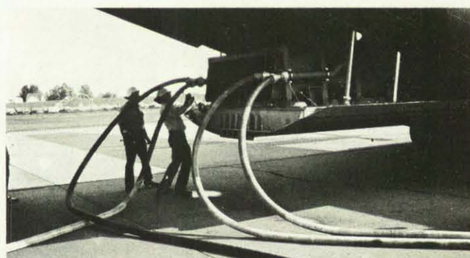
In vier bis fünf Minuten wird der Löschwasserbehälter über vier genormte B-Schläuche der Feuerwehr mit 12 200 l Wasser gefüllt.
