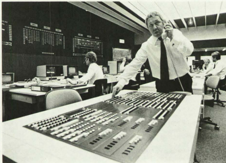
Die größte computergesteuerte Feuerwehr-Einsatzzentrale Europas wurde am 9. November in Hamburg in Betrieb genommen. Das mit einem Kostenaufwand von 12 Millionen DM errichtete Einsatzsystem nimmt automatisch Notrufe entgegen und alarmiert ebenso selbsttätig die entsprechenden Wehren und Hilfskräfte.
