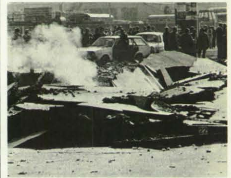
Auf einer Länge von 700 Metern aufgerissen: Straße im Industriegebiet von Offenbach nach der Explosion des Fernheizkanals.
