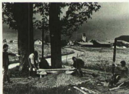
„Holzbearbeitung“ beim OV Wangen: Sitzbänke für Spaziergänger.
