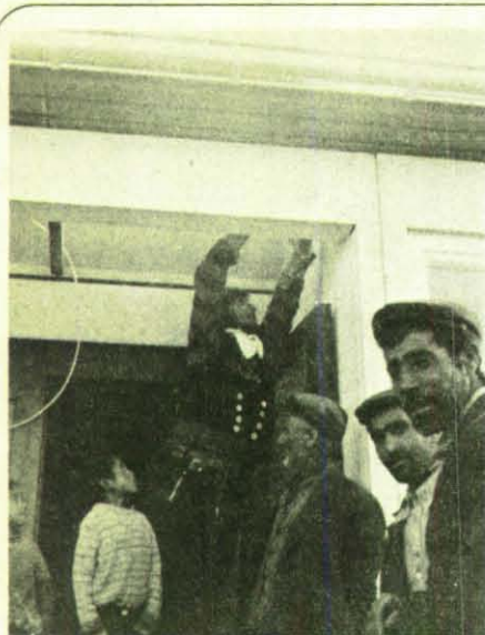
Die neue Dorfschule in Umuttepe. Ein Zimmermann des Malteser-Hilfsdienstes legt letzte Hand an den Eingang. Kinder aus Umuttepe schauen zu. Die Männer des Dorfes, das 2 300 m hoch über dem Meeresspiegel liegt, standen seit Beginn der Bauarbeiten täglich von neuem rund um den Bauplatz.
