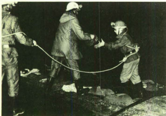
THW-Helfer bauen im Rahmen einer Einsatzübung Sandsäcke ein.
