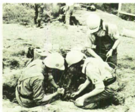
Links: Vorbereitungen zur Sprengung der Stubben: Herstellen des Laderaumes. Rechts: Aufsetzen der „Lehmnudeln“.
