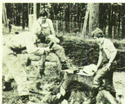
Links: Vorbereitungen zur Sprengung der Stubben: Herstellen des Laderaumes. Rechts: Aufsetzen der „Lehmnudeln“.
