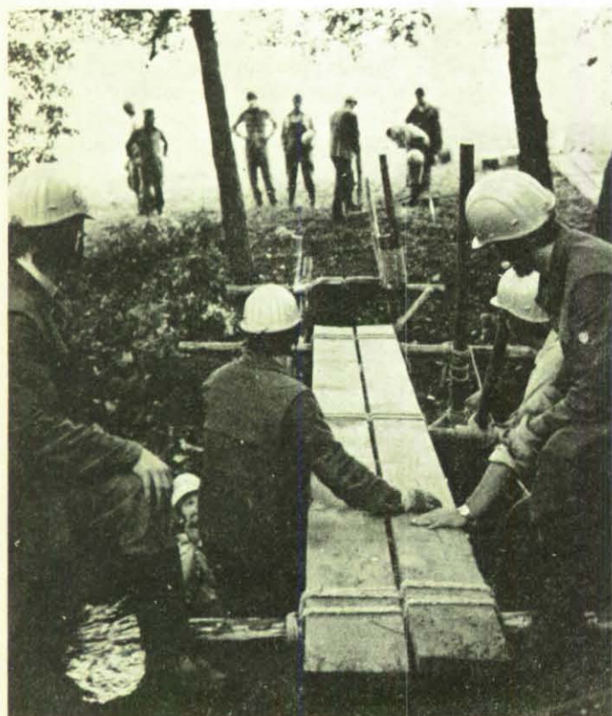
Helfer des Technischen Hilfswerkes beim Bau eines Steges über die Bühlertal.
