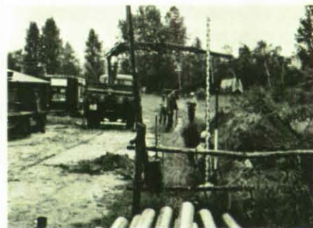
Hilfe für das Museumsdorf in Düppel: Das THW verlegte Abwasserleitungen.
