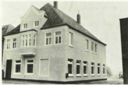
Die neue Unterkunft des THW-Ortsverbandes Norden – nach erfolgtem Umbau.
