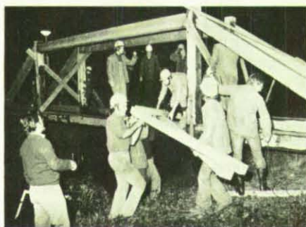
Einen Hängesteg von 48 m Länge bauten die 40 Helfer des OV Saarburg innerhalb von drei Stunden.
