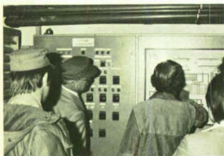
Einweisung der THW-Techniker in die umfangreiche technische Ausstattung einer Schutzbauanlage.
