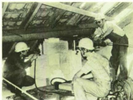
Mit Hydropressen hoben die Helfer des THW das 8 t schwere Dach langsam in die Höhe.
