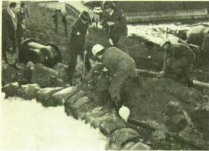
**90 THW-Helfer aus fünf Ortsverbänden im Einsatz am Damm des Bostalsees: Ein Sandsackdamm regulierte zunächst das abfließende Wasser.**
