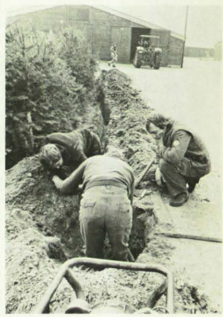
Sorgfältig wird von den Helfern das Zuführungskabel zu den Notrufsäulen verlegt.
