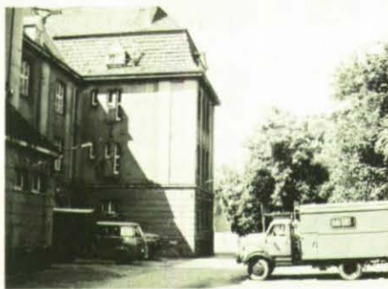
Die Unterkunft des THW-BV Hamburg-Altona in der Notkestraße.
