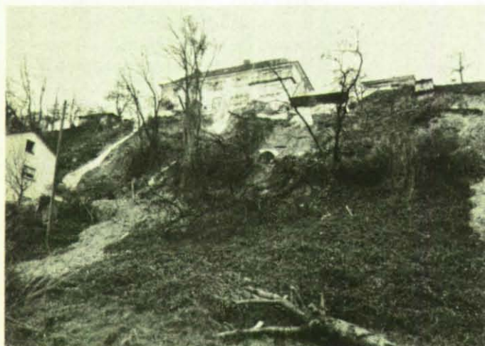
Der abrutschende Hang von unten aus gesehen.
