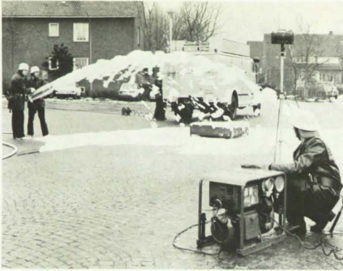
Ablöschen eines Ölbrandes mit Mittelschaumrohr. Von den anderen Feuerwehrleuten wird die Beleuchtung der Einsatzstelle geübt, einmal mit Teleskop-Flutlichtscheinwerfer vom Fahrzeug aus, zum anderen mit Scheinwerfer, Stativ und transportablem Generator.
