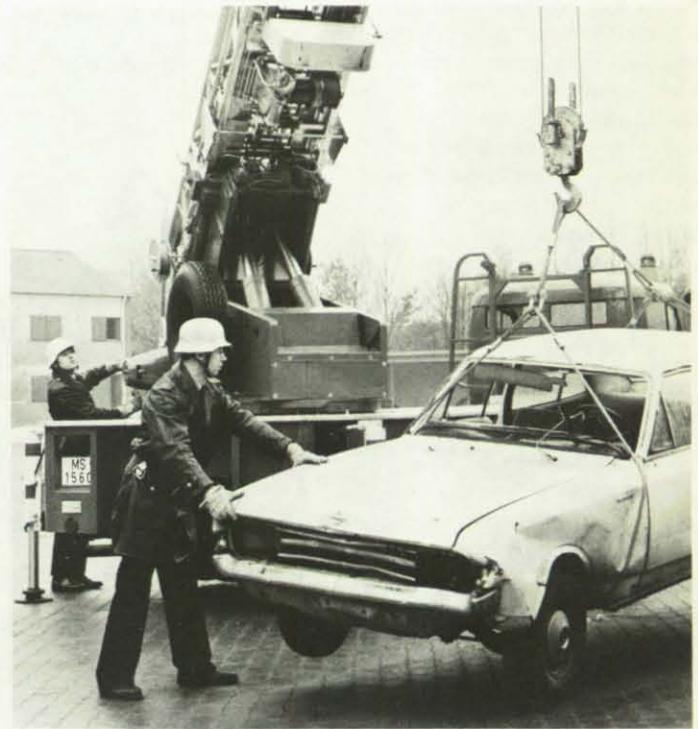
Schrottfahrzeuge sind ideale Objekte, um das Bergen von Eingeschlossenen oder das Anheben und Transportieren von Fahrzeugen nach Unfällen zu üben.
