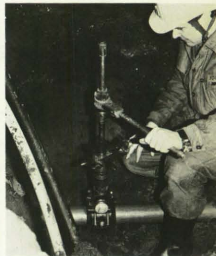
Sorgfältig holt der THW-Helfer, nachdem die Hauptleitung angebohrt ist, die Rohrspindel unter Gegendruck zurück.
