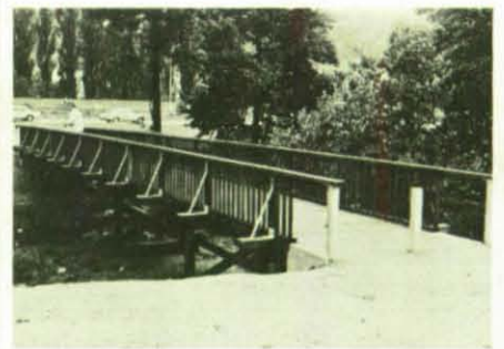
Harmonisch fügt sich die vom THW errichtete Fußgängerbrücke in das Landschaftsbild ein.
