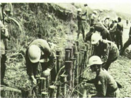
Praktische Ausbildung: Befestigung des Uferstreifens an der Schlei.
