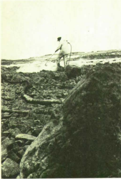
Zum Reinigen werden Heißwasserstrahlgeräte eingesetzt.
