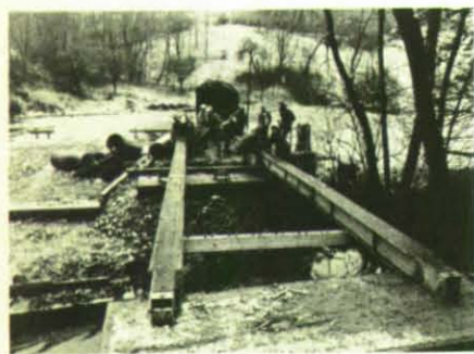
Geschafft! Der Brückenrahmen liegt auf den beiden Lagern auf.
