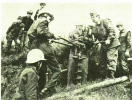
Unter fachkundiger Aufsicht arbeiten die Junghelfer mit dem Erdbohrgerät.
