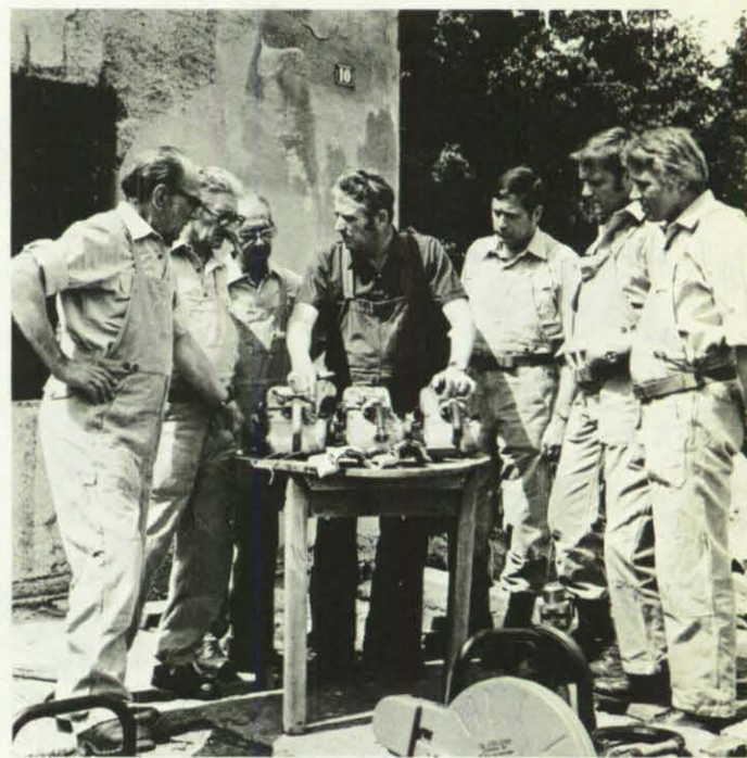
Erläuterung des Bergungs-Mehrzweckgeräts, das für Säge-, Trenn- und Bohrarbeiten an Holz, Beton, Steinen und metallischen Baustoffen geeignet ist. Begriffsbestimmungen und Arbeitstechniken müssen den Lehrern in Fleisch und Blut übergehen.
