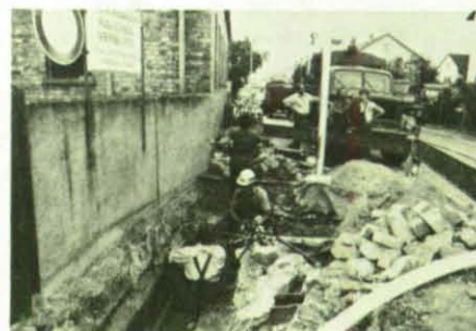
Helfer des THW-Ortsverbandes Freiburg bereiten Dichtigkeitsprüfungen vor.
