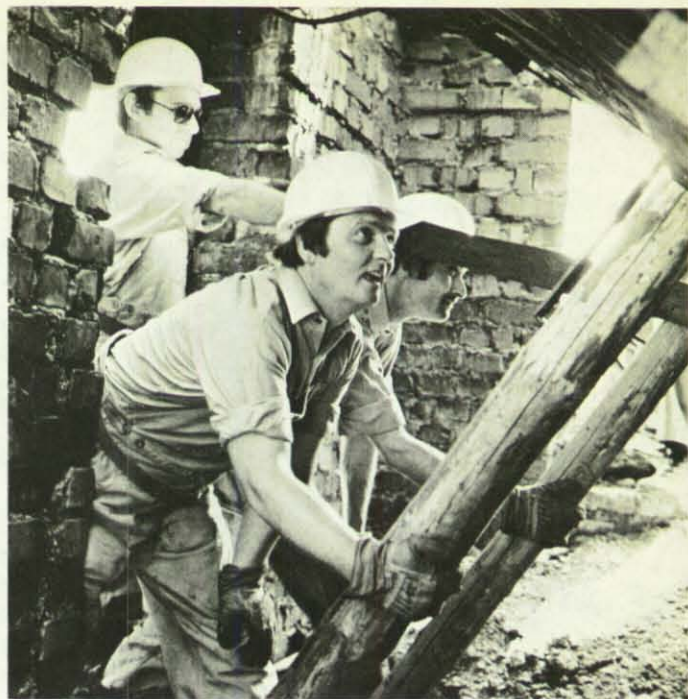
Damit sie bei der Ausbildung von Einsatzkräften in Behörden und Betrieben jeden Handgriff vormachen können, erlernen die Fachlehrer gründlich die Lehrmethoden und Arbeitstechniken, z. B. bei Abstützungen und Aussteifungen.
