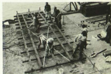
Der Schwimmsteg wird an Land zusammengebaut.
