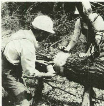
Die Sprengung wird vorbereitet: Anlegen der Sprengschnur.
