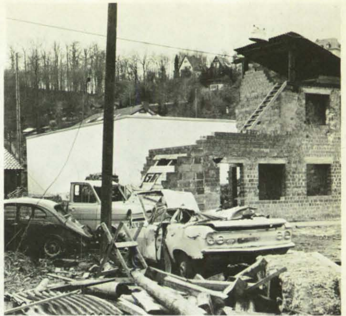
In dieser, vom THW selbst erbauten, relativ bescheidenen Übungsanlage (Trümmerhaus mit unterirdischer Kriechstrecke) werden die Helfer auf den Ernstfall vorbereitet.
