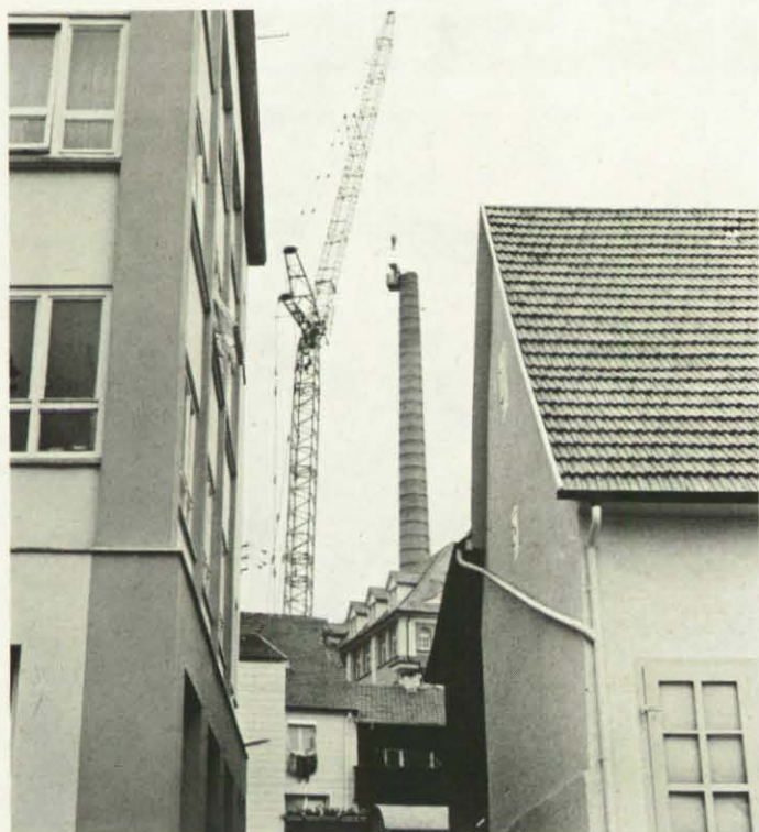
Dieser Fabrikschlot mußte Stein um Stein abgebaut werden.
