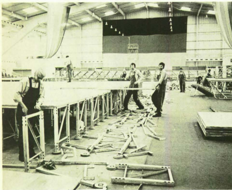
Umfangreiche Montage- und Demontearbeiten an Wettkampfanlagen und Hallendekorationen waren von den THW-Helfern in Hannover durchzuführen.
