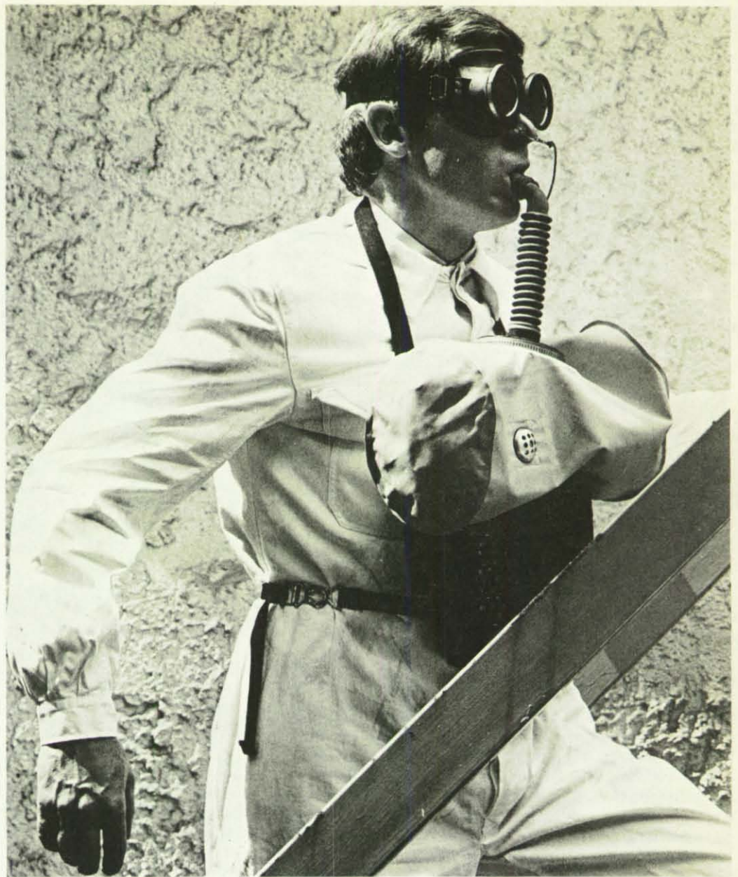
Für den Beginn der Benutzung ist ein Quickstarter vorhanden, der nach dem Anlegen des Gerätes gestartet wird und in wenigen Sekunden den Atembeutel mit Sauerstoff füllt. Die Sauerstoffabgabe paßt sich dem jeweiligen Sauerstoffbedarf des Geräteträgers an.
