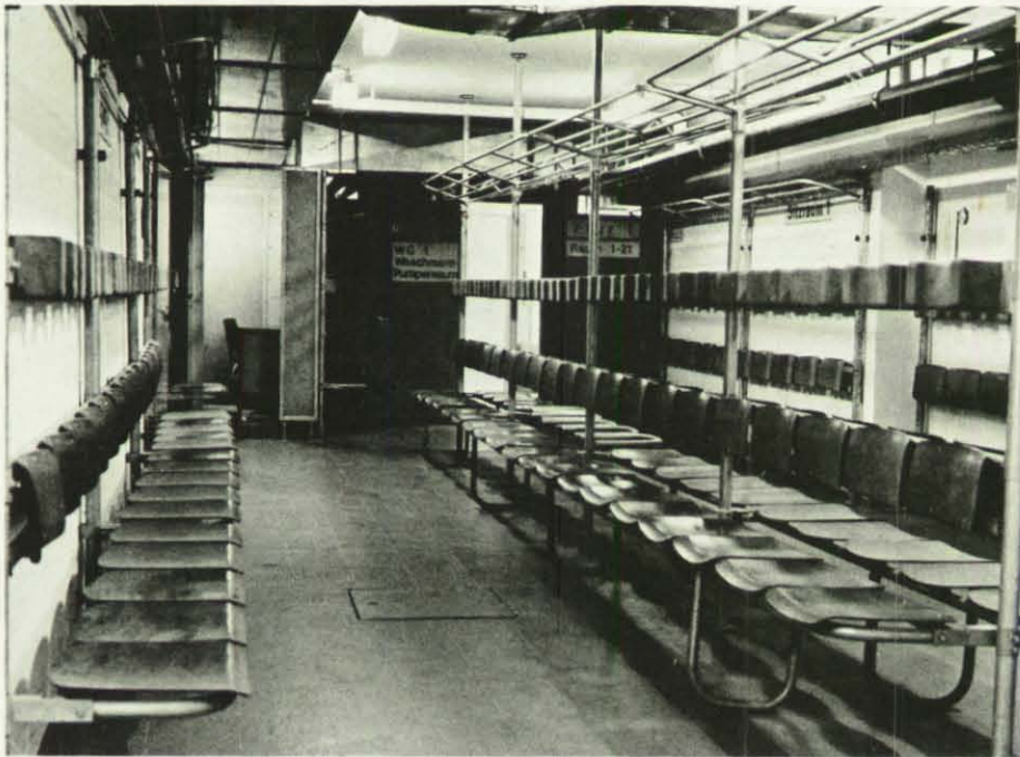
In diesem instand gesetzten Tiefbunker gibt es 1137 Schutzplätze. Er ist komplett mit der für solche Anlagen vorgeschriebenen Technik versehen. Selbst eine Küche zur Herstellung einfacher warmer Mahlzeiten und Getränke aus eingelagerten Vorräten ist vorhanden.
