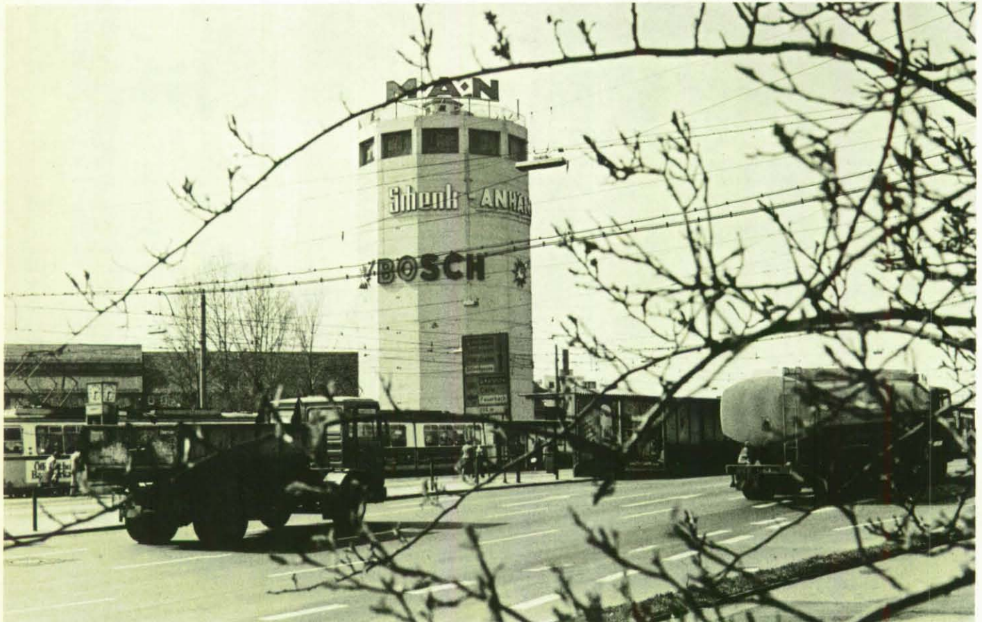
In diesem Hochbunker würden nach seiner Nutzbarmachung 2200 Menschen Schutz finden. Er wird z. Z. teilweise als Beobachtungsstelle der BAMSt genutzt.
