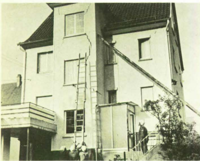
Ob dieses Haus, das die Besitzer eben frisch renoviert hatten, nun der Spitzhacke zum Opfer fällt, ist noch nicht sicher. Zunächst retten die THW-Helfer, was zu retten ist.
