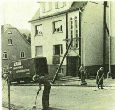
Vorläufig nicht mehr bewohnbar ist dieses Haus in Tailfingen. Die Bewohner wurden evakuiert.
