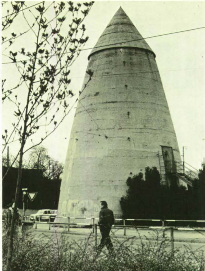
Dieser Winkelturm-bunker, ein Relikt aus dem Zweiten Weltkrieg, gehört auch zu den wieder instand gesetzten Schutzanlagen. Kapazität: 200 Schutzplätze.
