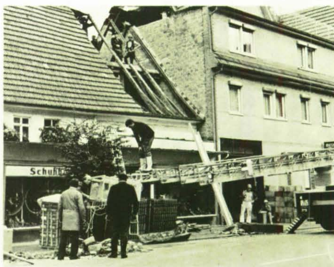
Auf die Dauer wird man hier wohl den Dachstuhl erneuern müssen. Wegen der unsicheren Wetterlage begnügte man sich aber zuerst einmal, das Dach provisorisch zu reparieren.
