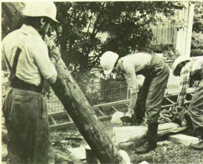
Mit Motorsägen schnitten die THW-Helfer die Baumstämme zum Abstützen der Häuser zurecht.
