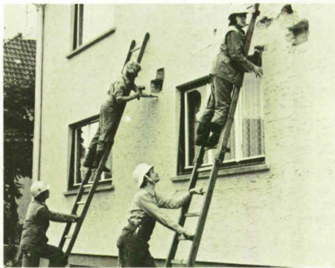
Hier werden Löcher für die Stützen in die Hausmauer gebrochen.
