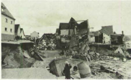
Auf diesem Bild ist zu erkennen, welches Ausmaß die Schäden nach dem Dambruch in Katzwang erreichten.
