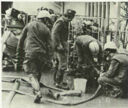
Eine weitere Hilfsmaßnahme der THW-Helfer: das Auspumpen der Keller.
