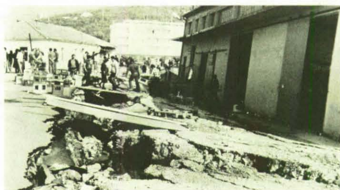
Glücklicherweise war das einsturzgefährdete Lagerhaus in der Hafenstadt Zelenika gut gefüllt, so daß die Bevölkerung wenigstens mit Nahrungsmitteln versorgt war.
