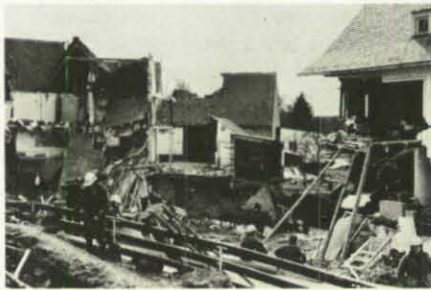
Eine der Hauptaufgaben des THW war das Abstützen einsturzgefährdeter Häuser.
