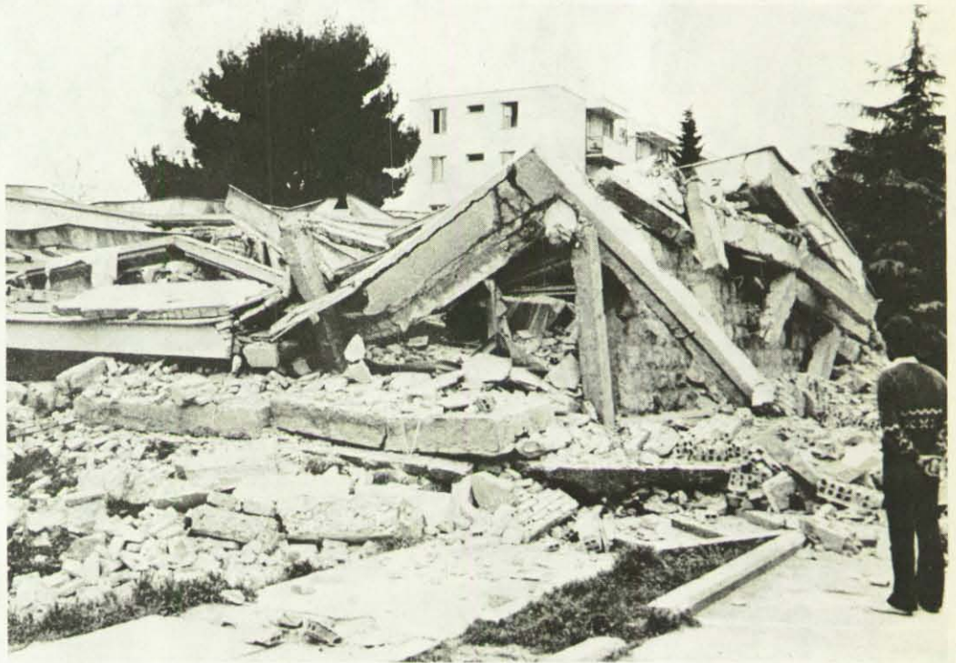
Mehrere Erdstöße zerstörten über 10 000 Gebäude oftmals bis auf die Grundmauern, hier das Gerichtsgebäude in der montenegrinischen Hafenstadt Bar.
