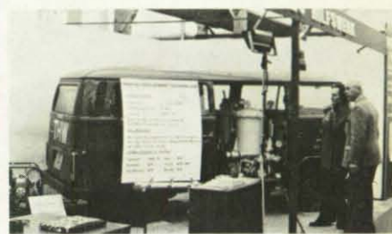
Die Trinkwasseraufbereitungsanlage zog viele Besucher der Rheinland-Pfalz-Ausstellung an den Stand des THW.
