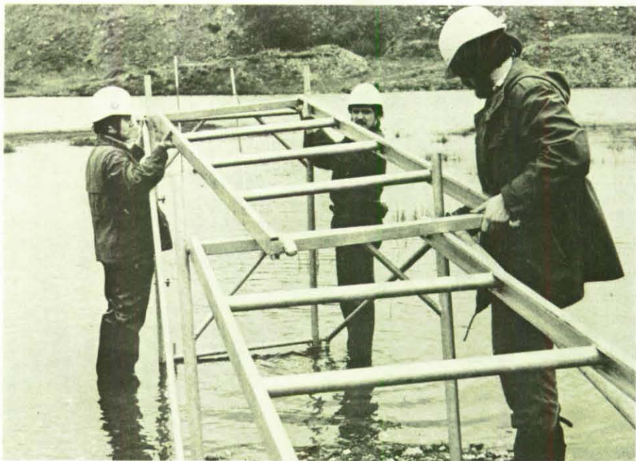
Zum ersten Male wurde ein neues Steckrahmengerüst erprobt und auf Tauglichkeit überprüft.
