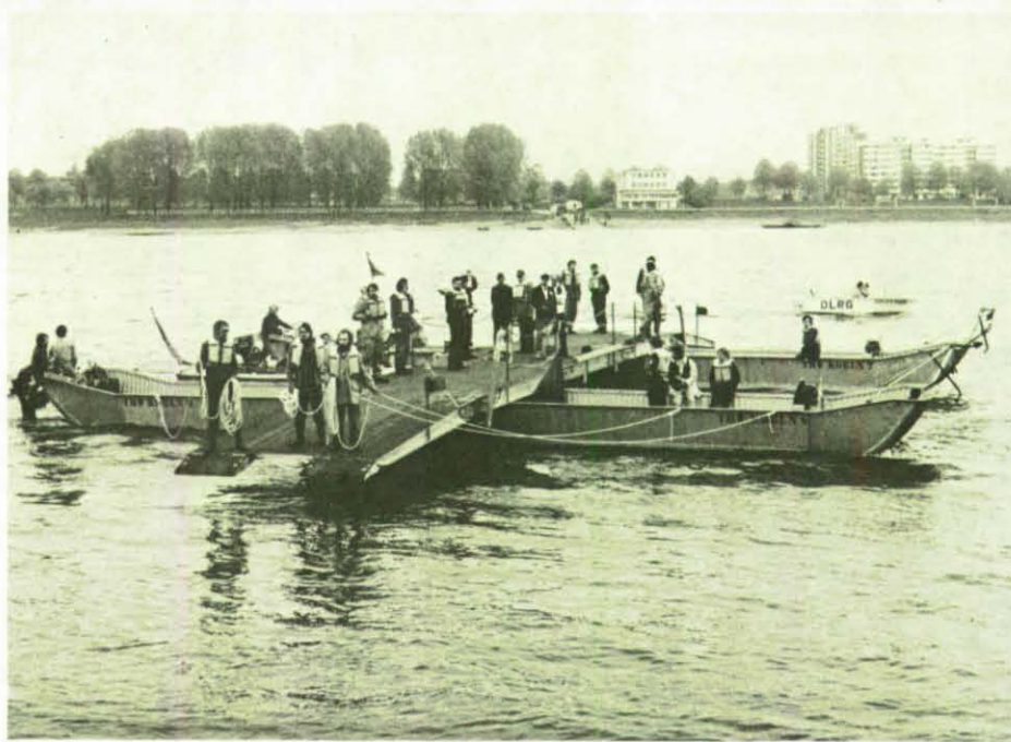
Spektakulärster Teil der großen THW-Übung war der Bau und der Einsatz einer unsinkbaren Ponton-Fähre.
