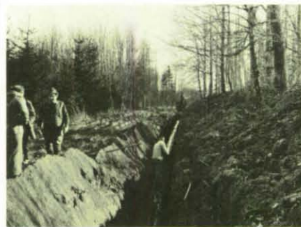
Abb. 4: Verlegung einer Verbundleitung zwischen Duderstadt und Bad Lauterberg im Zonenrandgebiet.
