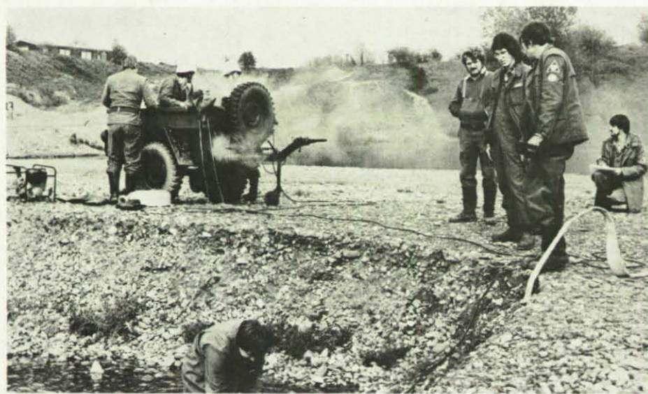
Mit Spezialpumpen wurden kleinere Kieslöcher leer gepumpt.
