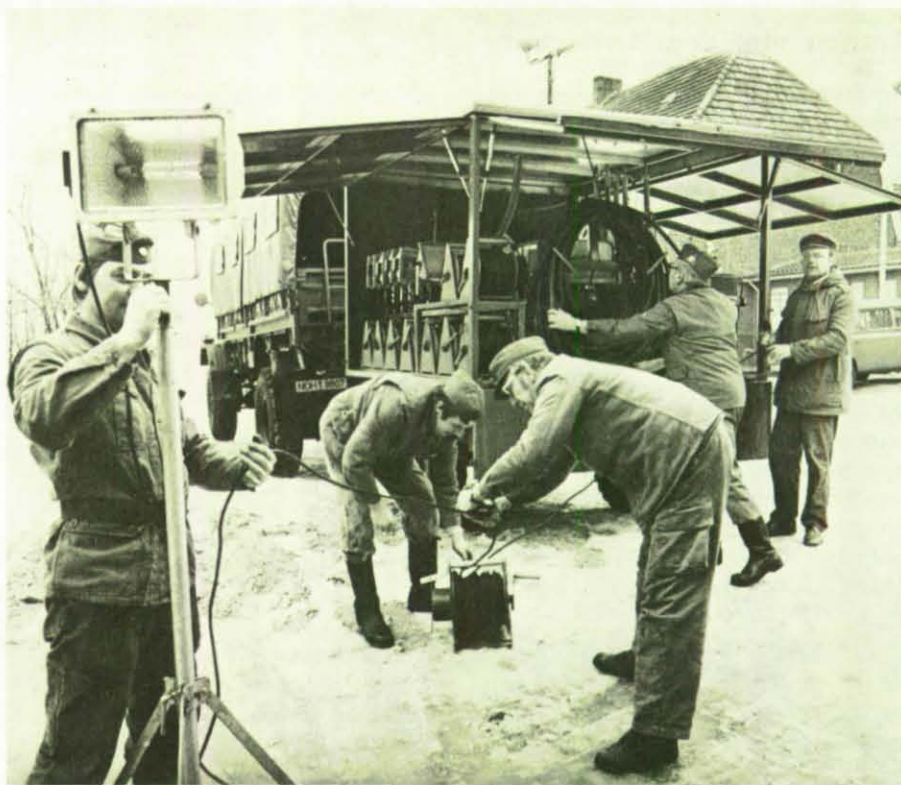
Mehrfach bewährt hat sich bereits das in 180stündiger Eigenleistung erstellte mobile 42-kVA-Notstromaggregat.
