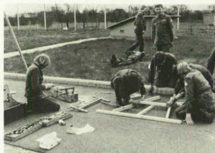
Junghelfer bei der Lösung der Wettkampfaufgabe „Bau eines Tafelgestells“.
