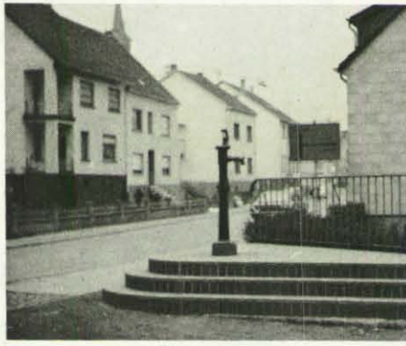
Abb. 1: Sicherung der Trinkwassernotversorgung durch Handpumpe in einem Versorgungsbereich der Gemeinde Großrosseln im Saarland.
