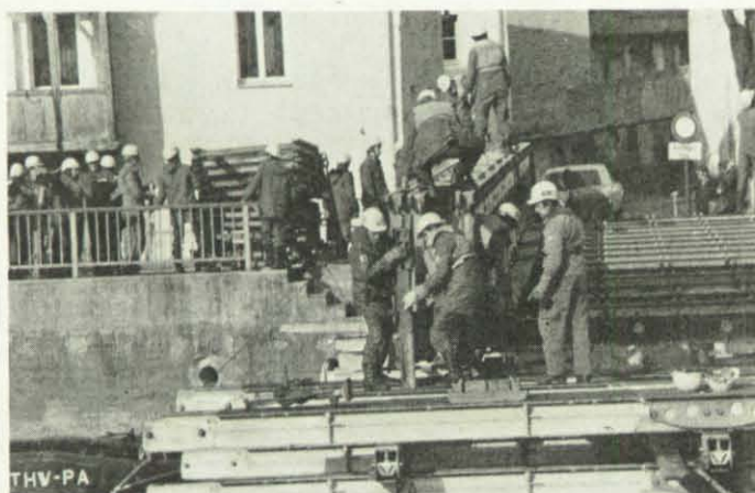
THW-Helfer bauen die einzelnen Teile der Brücke zusammen.
