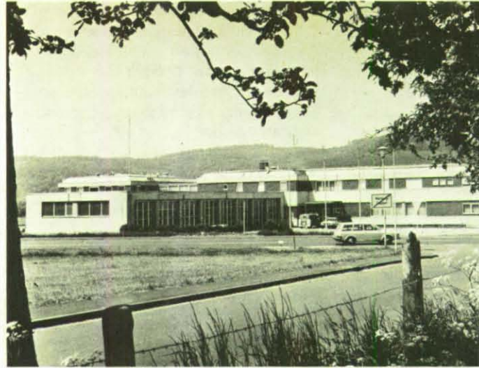
Blick auf das Ausbildungszentrum der hessischen Jugendfeuerwehr in Marburg/Cappel.
