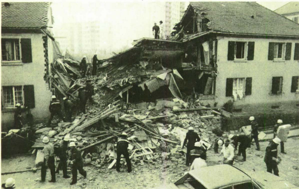
Feuerwehr und THW bergen die Reste des Hausrats aus dem völlig zerstörten Wohnhaus.
