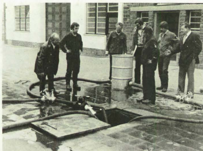
Füllwasserkessel zwischen Steigleitung und Pumpenaggregat.
