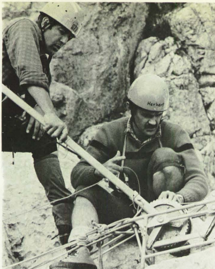
Abb. 9: Mit einer Stahlseilwinde können Verunfallte und Helfer aufgesiebt werden, falls eine Bergung nach oben vorteilhaft erscheint. Peter S. Harding, Berufsluftretter aus den USA, und Notarzt Dr. Herbert Forster beim Einlegen des Stahlseils.
