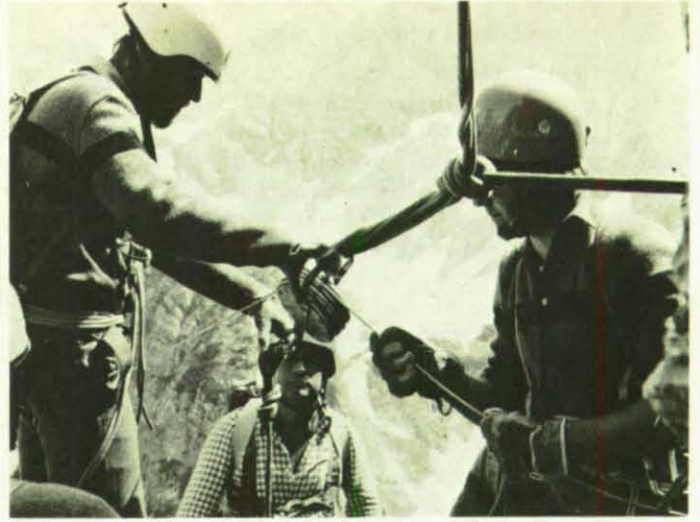
Abb. 6: Einsatz der Bremsscheibe aus Buchenholz mit Kunststoffeinlagen, 15 cm \varnothing . Über die Bremsscheibe wird das belastete Stahlseil abgelassen. Die Verankerung besteht aus dreifach gelegten Bergseilen. Links im Bild der Autor unseres Beitrags, Dr. K. P. Götzfried.
