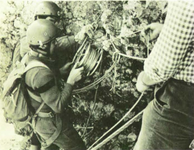
Abb. 4: Arbeiten mit dem Stahlseil, 100 m, 5 mm \varnothing . Die Stahlseilhassel wird mit einem Bügel möglichst im rechten Winkel zur Bremsscheibe an Felshaken aufgehängt.
