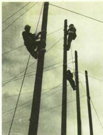
Akrobatik am Mast demonstrierten die Helfer der E-Gruppen beim Auflegen der Leiterseile.
