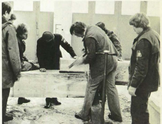
Eine Außengerüstseite wird abgebunden. Im Hintergrund der für den Holztransport zur Baustelle von der KSB Hoya ausgeliehene Langholzanhänger.
