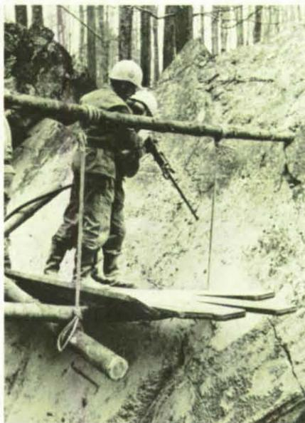
Ein Teil der Bohrlöcher mußte von einer aus Behelfsmitteln errichteten Arbeitsbühne aus gebohrt werden.
