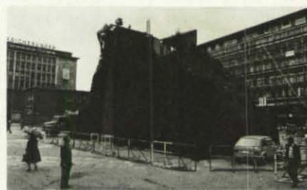
Nach nur fünftägiger Bauzeit ist der künstliche Berg für die Besteigung bereit. Das Stahlgerüst wurde mit Zeltplanen und Tarnnetzen abgedeckt, um dem ‚Mount Katzor‘ ein natürliches Aussehen zu verleihen.
