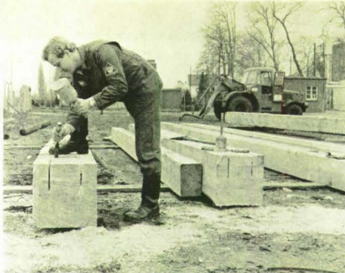
gearbeitet hatten: Waren während des Abbundes Einzelteile zu Baugruppen zusammengepaßt worden, so mußten sich jetzt die Baugruppen zum Gesamtbauwerk zusammenfügen. Und was mancher wohl vorher nicht zu wagen gehofft hatte: es paßte. Nur hier und da, wo Holzverbindungen mit Maschinenbauerpassungen bearbeitet worden waren, mußte nachgearbeitet werden.
