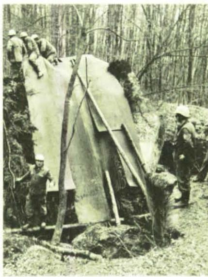
Um den Splitterschutz sicherzustellen, wurden die bis zu 1,80 m starken Stahlbetonplatten mit Förderbandgummibahnen, Faschinen und Maschendraht abgedeckt.
