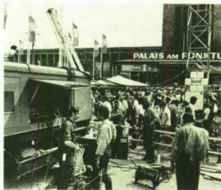
Mit dem 53-kVA-Aggregat wurde der Strom erzeugt und über zwei Baustellenverteiler und 1400 m Kabel an die Stände und Buden verteilt.
