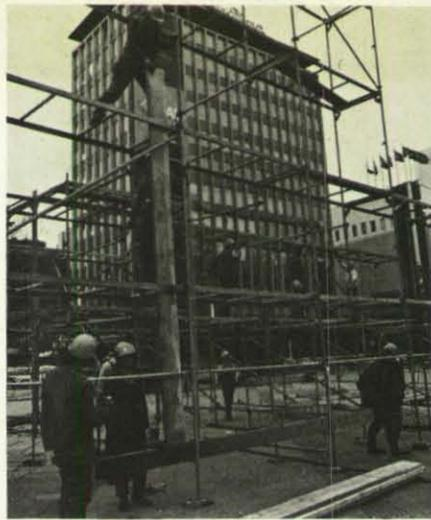
Das aus Stahlrohren bestehende Grundgerüst ist fertig. Die Helfer beginnen mit dem Bau der Steilwand.
