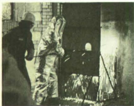
Die Bergungseinheiten des THW setzten bei der gemeinsamen Großübung auch die Sauerstofflanze ein.
