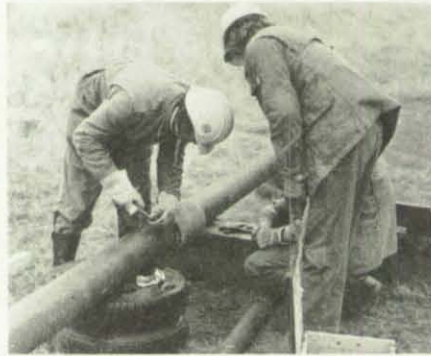
Auch bei Regen und Kälte arbeiteten die Helfer der Gas-Wasser-Gruppe beim Verbinden von Leitungen äußerst präzise.
