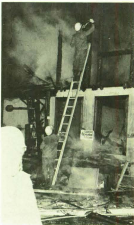
Die THW-Bergungsgruppe unterstützte die Feuerwehr u. a. durch Einreißen einsturzfähiger Gebäudeteile.
