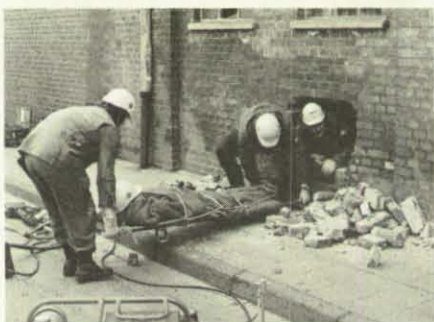
Der Mauerdurchbruch ist geschafft: Hildesheimer THW-Helfer beim „Verletzentransport“.
