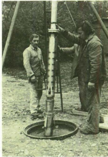
Abb. 10: Einbau einer elektrischen Unterwasserpumpe aus korrosionsbeständigem Stahl in einen Trinkwasser-Notbrunnen der Stadt Ulm.
