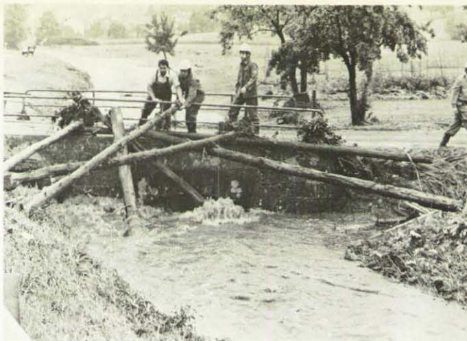
An zahlreichen Brücken und Wehren waren die THW-Helfer im Einsatz, um den Abfluß der Wassermassen zu gewährleisten. Angeschwemmte Baumstämme und sonstiges Treibgut mußte entfernt werden.
