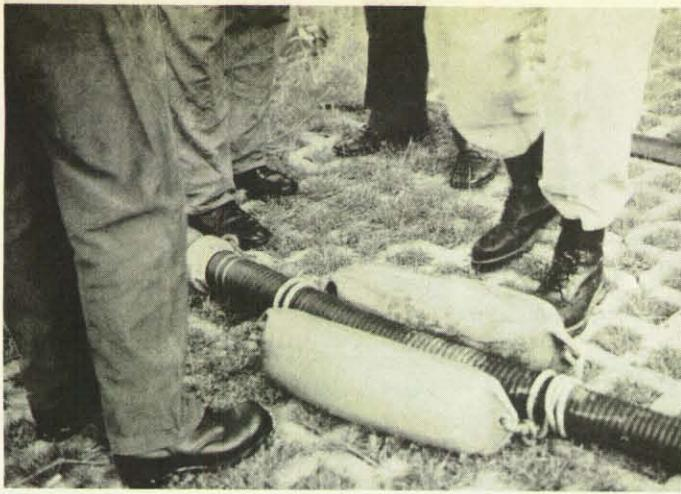
**Bild 16:** Saugleitung der Rohwasserpumpe mit schwimmendem Saugkorb.
