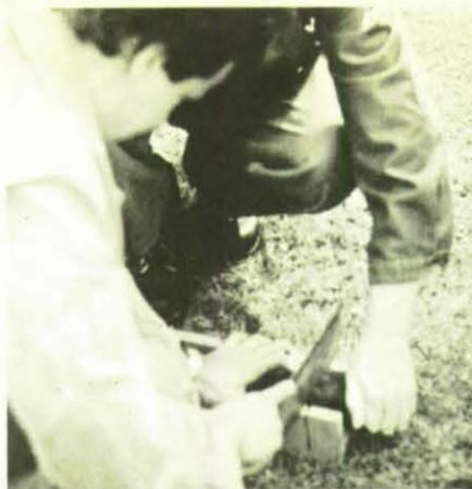
Bild 19: Abhängen eines Kunststoffrohres zum Herstellen einer Verbindung.
