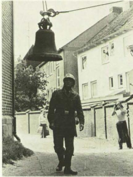
Wegen der engen Treppe im Glockenturm mußte die fünf Zentner schwere Glocke außenwandig abgeseilt werden.
