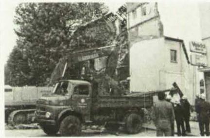
Die Helfer des THW-Bergungszuges errichteten eine Materialrutsche, über die Trümmerreste abgelassen wurden.
