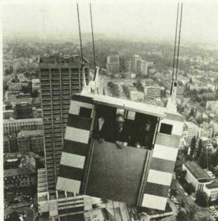
Die Seilbühne kann vom eigenen Steuerstand oder dem des Mobils gelenkt werden. Sie bewegt sich in Schrägfahrt aufwärts und kann mittels der Steuerseile in der Horizontalen präzise an den
