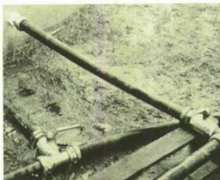
Bild 20: Fertige Rohrverbindungen mit Absperr-schiebern und Behälteranschlüssen.
