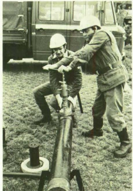
Der Instandsetzungsdienst demonstriert das Anbohren einer unter Druck stehenden Leitung.
