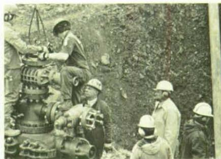
schen Spezialisten für Bohrunfälle, Paul „Red“ Adair, gelang es, das Bohrloch abzudichten. Nach zehntägiger Vorarbeit setzte er ein zehn Tonnen schweres Abschlußventil auf und verschloß damit die Bohrung. Unser Foto zeigt „Red“ Adair (3. von links) bei der Aktion.
