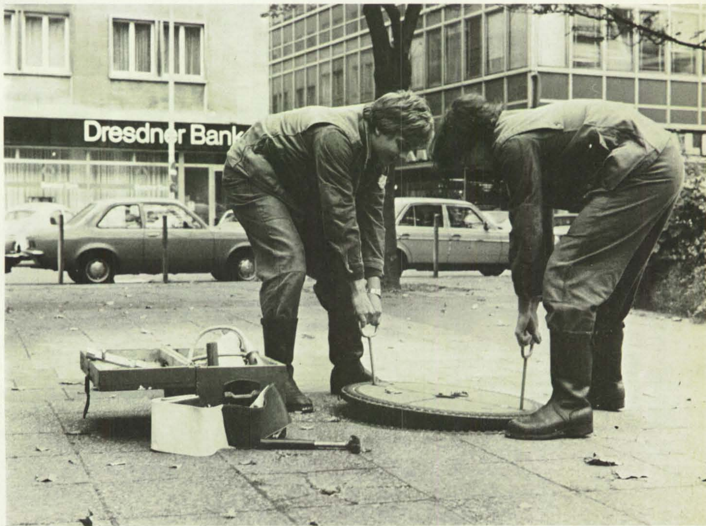
Kaum ein Passant wird vermuten, daß sich unter dieser Abdeckplatte ein Trinkwasser-Notbrunnen verbirgt.
