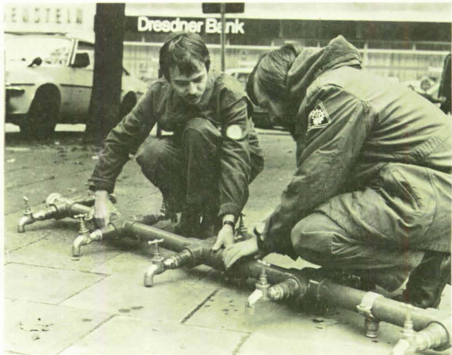
Oben: Die im Brunnen-schacht gelagerten Gruppenzapfstellen sind zerlegbar. Eine der War-tungsaufgaben ist der Zusammenbau und die Überprüfung der Funk-tionsfähigkeit.
