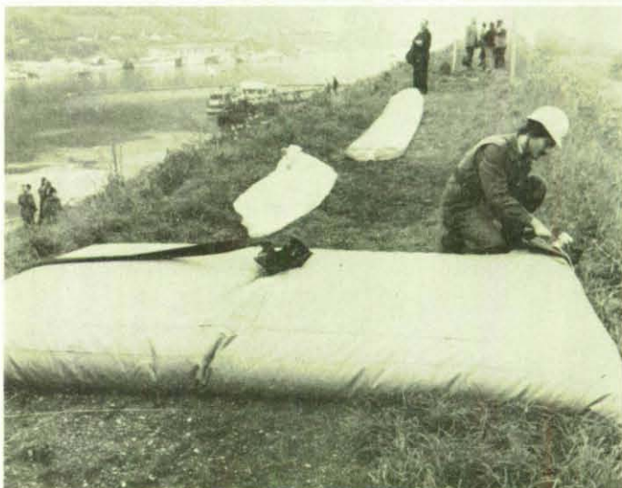
Bild 9: Befüllen eines geschlossenen Kunststoff-Falldanks mit ölverunreinigtem Wasser.
