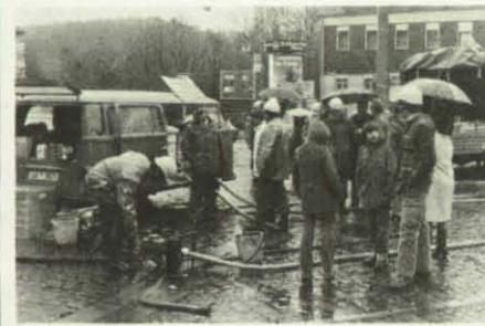
Zahlreiche Zuschauer verfolgten die Aufbereitung des Rohwassers zu Trinkwasser.
