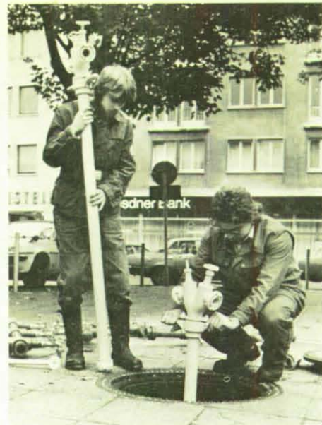
Oben: Sämtliche notwendigen Gerätschaften, die für den schnellen Aufbau einer Zapfstelle für Trinkwasser nötig sind, befinden sich in dem Brunnen-schacht.
