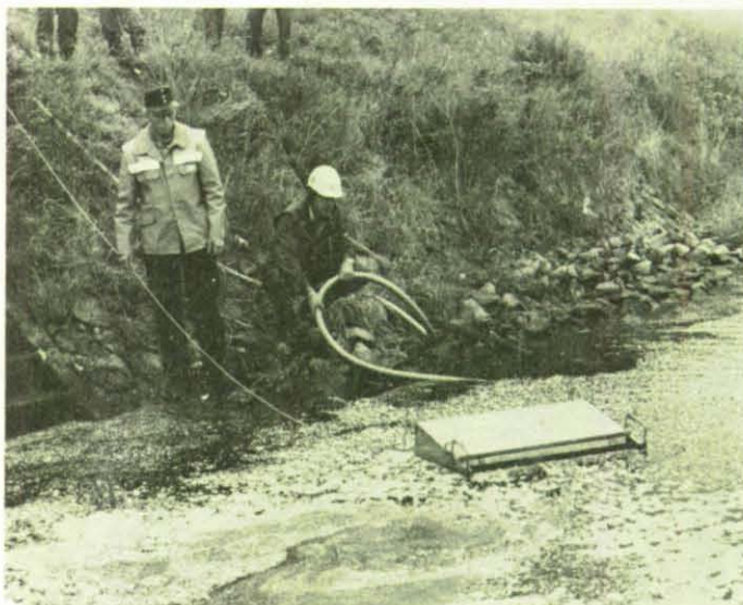
Bild 8: Schwimmende Absaugvorrichtung für die Ölförderpumpe (Skimmer) aus dem AÖ-Satz des THW-Instandsetzungsdienstes.
