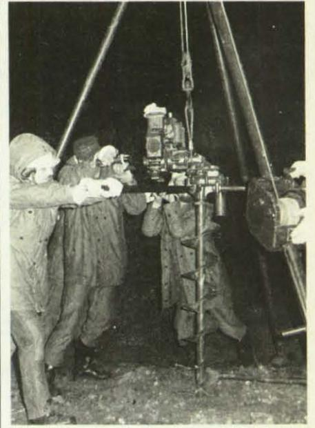
Mehrere Helfer sind nötig, um das Feldbohrgerät zu bedienen.
