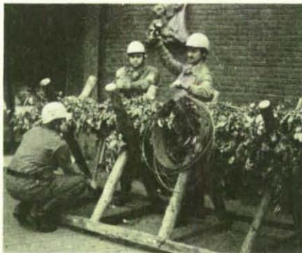
Mit dem Bau einer Bekleidungs- und Wasserfaschine auf einer Faschinenbank demonstrierten die THW-Helfer ihr Können.
