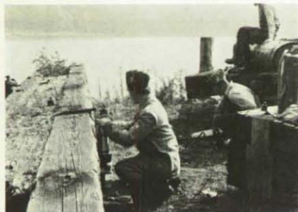
Eine der Übungsaufgaben war das Anheben einer schweren Last mit Hilfe einer hydraulischen Presse.
