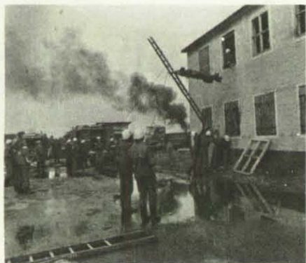
Ein Übungshaus auf dem Truppenübungsplatz Munsterlager bot ideale Möglichkeiten, den Leistungsstand der THW-Helfer zu überprüfen.
