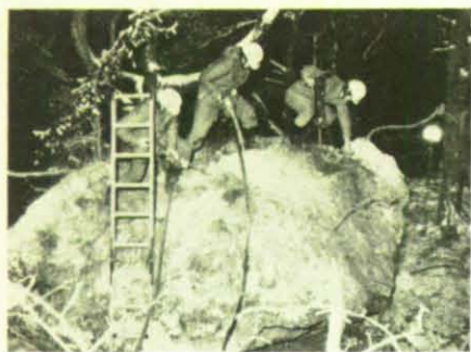
Mit Kompressorhämmern versuchten die THW-Helfer den 16 cbm großen Felsen abzutragen.
