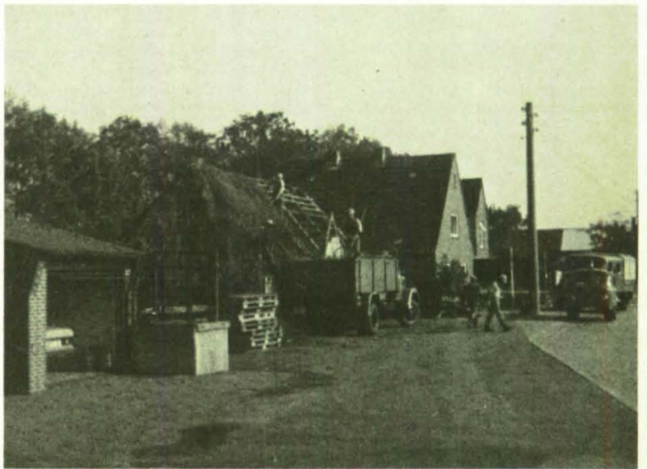
Insgesamt fünf Lkw-Ladungen abgetragenes Reet mußten die THW-Helfer abtransportieren.
