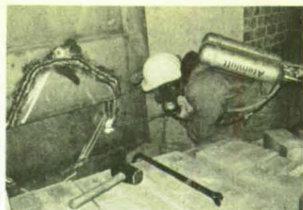
Mit Schneidbrennern mußten die THW-Helfer Stahltüren öffnen, um an die „Verletzten“ heranzukommen.
