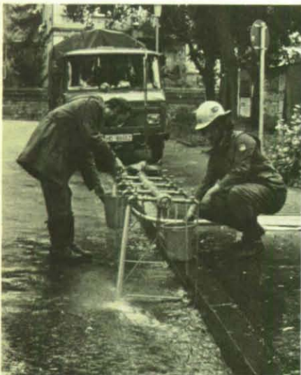
THW-Helfer nehmen die Trinkwasserausgabestelle an einem Notbrunnen in Betrieb.
