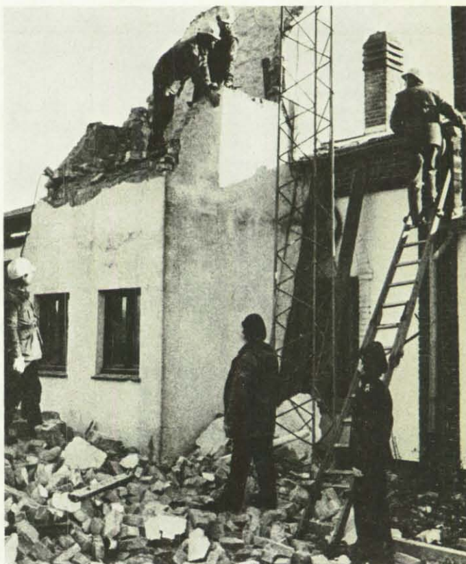
Flensburger THW-Helfer bei den Abbrucharbeiten auf dem unteren Teil des Turmes.
