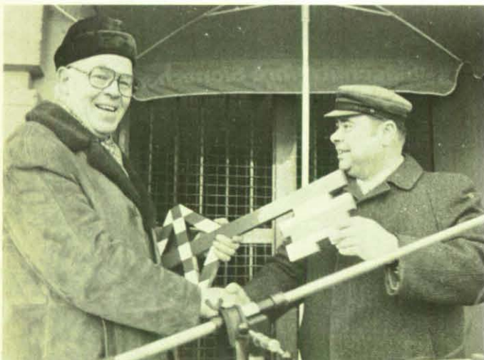
Oberbaurat Günter Knappe (rechts) überreicht Bremens Innensenator Helmut Fröhlich einen symbolischen Schlüssel zu dem instandgesetzten Schutzbauwerk in Bremen.
