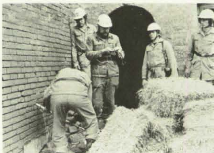
Eine Sprenghelfergruppe bereitete einen baufälligen Schornstein zur Sprengung vor.
