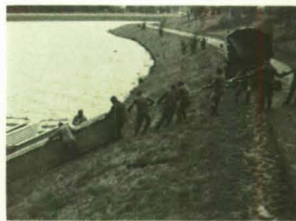
Mit vereinten Kräften brachten die THW-Helfer die Boote für den Bau einer Fähre zu Wasser.
