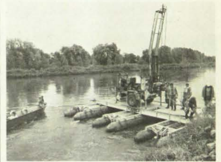
Auf einer Acht-Tonnen-Schlauchbootfähre war das Bohrgerät aufgebaut.
