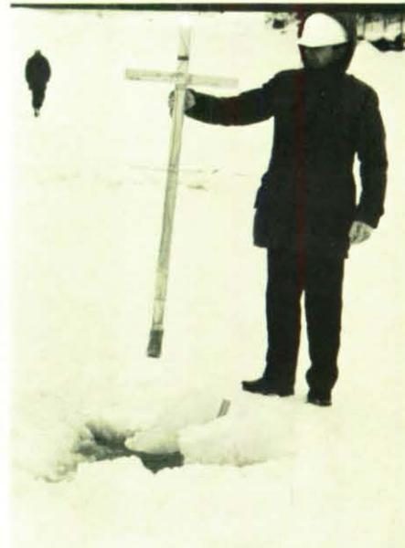
Fertige Sprengladungen an einer Holzlatte für eine Versenkentiefe von 1,20 m.
