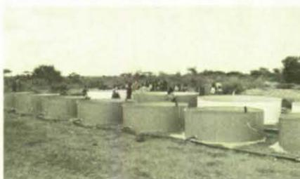
Die größte Trinkwasser-Aufbereitungsanlage mit neun Rohwasser- und sieben Reinwasserbecken wurde in Jalalagsi erstellt.
