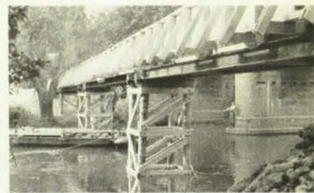
An vier Samstagen bauten die THW-Helfer des OV Gemünden eine Behelfsbrücke über die Saale.
