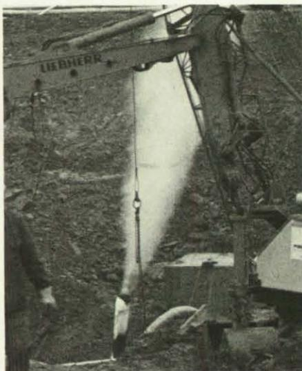
Aus dem abgebrochenen Bohrgestänge der Bohrung „FT 10“ schießt das Gas unter hohem Druck.
