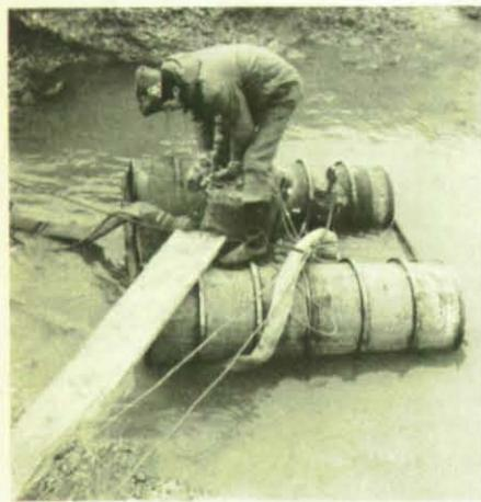
THW-Gerätewart Rolf Schablow installierte eine Tauchpumpe, um den Grundwasserspiegel abzusenken.
