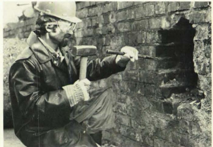
Sicherheitshinweis Nr. 15: Es ist verboten, ohne Schutzbrille, Schutzhandschuhe und Schutzhelm Stemmarbeiten durchzuführen (BVS-DV III Nr. 4.4.1).
