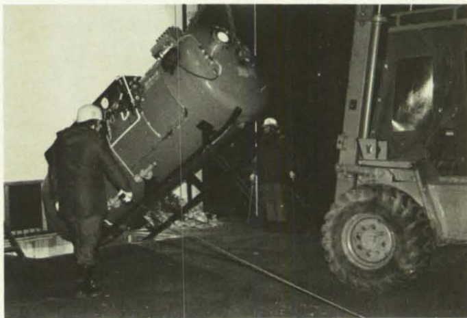
Mehrere Greifzüge waren notwendig, um das empfindliche Gerät sicher an Ecken und Kanten vorbei zu manövrieren.
