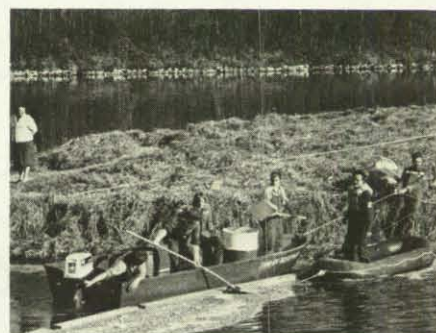
Das mit dem Bindemittel vermischte Öl wird abgeschöpft.
