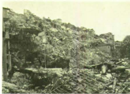
Durch das Beben zerstörte Häuser am Berghang der Stadt Laviano.
