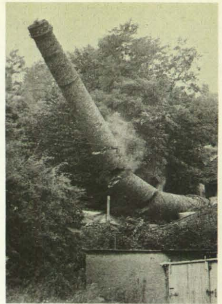
Nach einigen technischen Schwierigkeiten bei der Sprengung neigt sich der Schornstein und zerfällt.
