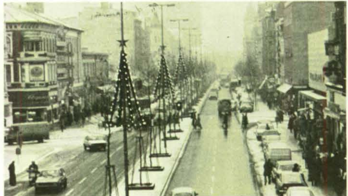
An 32 Laternen montierten die THW-Helfer leuchtende Weihnachtsbäume mit rund 3500 Glühlampen.
