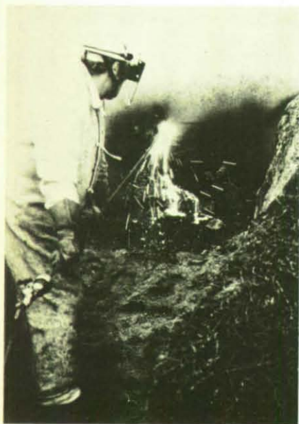
In eine 40 cm dicke und schwerarmierte Stahlbetonwand brannten die THW-Helfer drei 60 x 80 cm große Aussparungen mit der Sauerstofflanze.
