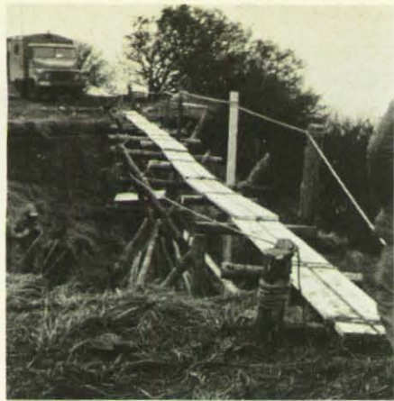
25 Meter lang war der „China-Steg“, den die Helfer des THW-OV Fehmarn an der Steilküste bauten.
