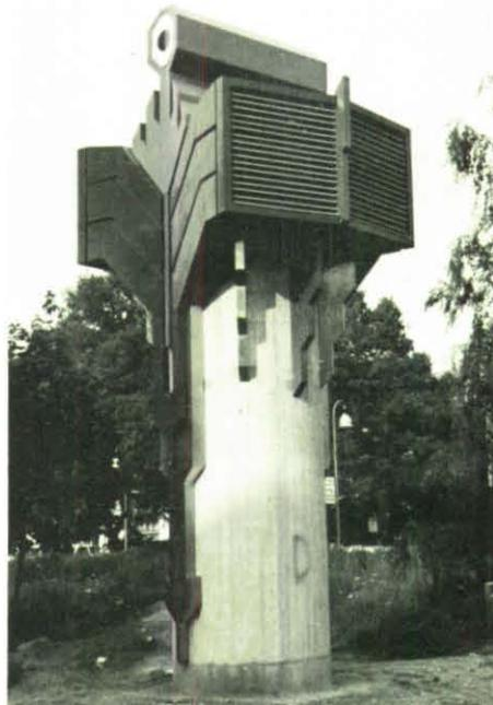
Rechts: Kein „Totempfahl“ ist dieses Gebilde; das 5 m hohe Bauwerk dient vielmehr der Luftversorgung eines neuen Großschutzraumes in einem U-Bahnhof.
