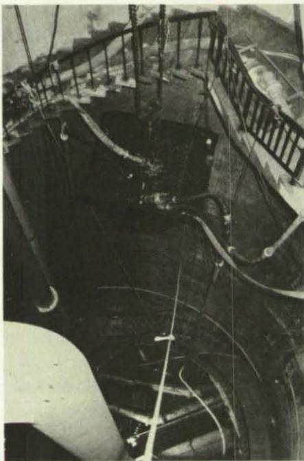
Zunächst wurde das Wasser in einen im Schacht angebrachten Stahlbehälter und von dort dann weiter an die Oberfläche gepumpt.
