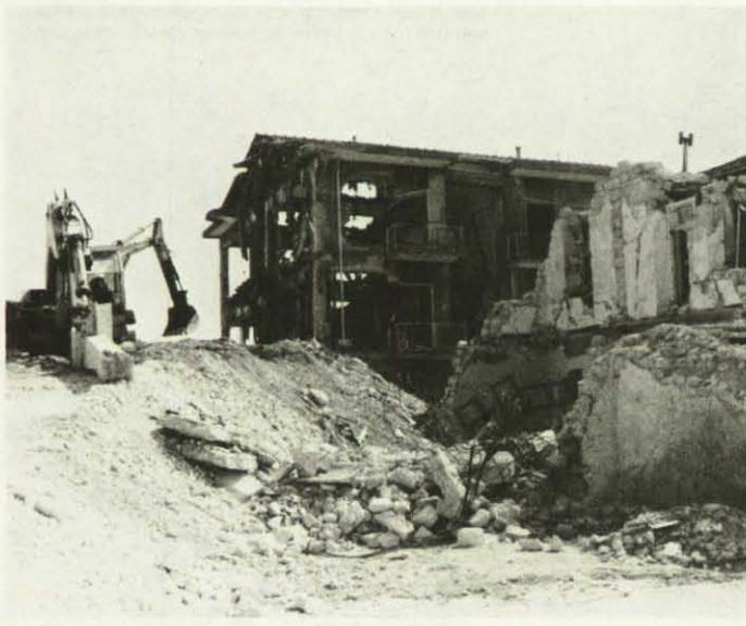
Auch die wenigen neueren Stahlbetonbauten wurden von dem Beben so stark in Mitleidenschaft gezogen, daß sie abgerissen werden müssen.
