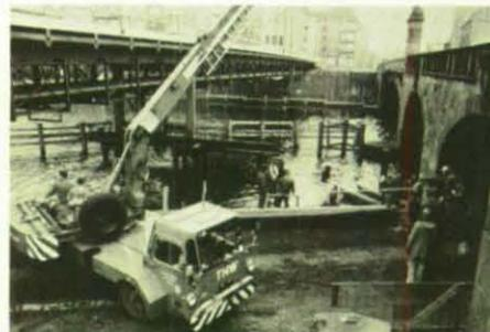
Mit dem THW-Kranwagen werden die ca. zwei Tonnen schweren Stahlrohre aus der Spree geborgen.
