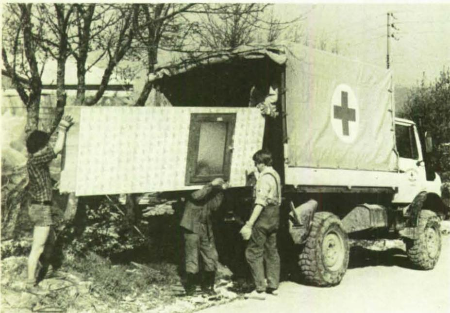
Links: Komplett bis auf den letzten Nagel werden die Fertighäuser geliefert und an Ort und Stelle von den deutschen Helfern zusammengebaut.
