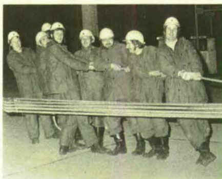
Mit einem Flaschenzug mußte ein GKW mit an- gezogenener Bremse 30 m von der Stelle bewegt werden.
