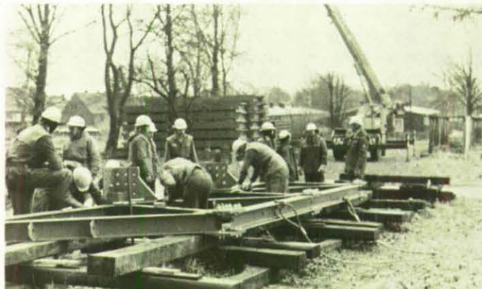
Wie Teile eines Stahlbaukastens wird die Brücke zusammengebaut.
