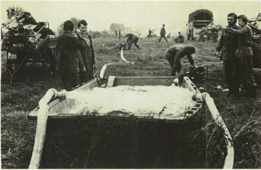
Bild 17: Helfer haben einen Pufferbetrieb aufgebaut. Mit dieser besonderen Betriebsart ist es möglich, unter Einsatz eines Zwischenbehälters eine große Förderstrecke zu überbrücken, auch wenn die zur Verfügung stehenden Pumpen sehr unterschiedliche Volumenströme haben.
