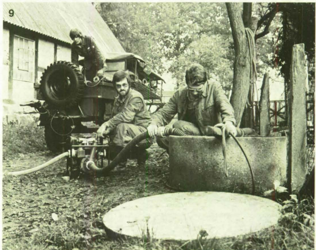
Bild 6: Mit einer Arbeitsleine wird die Elektro-Tauchpumpe ins Wasser abgelassen.
