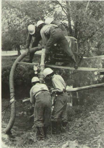
Die Pumpe zur Unterstützung der Wasserversorgung der Feuerwehren wird von THW-Helfern auf ein Gerüst montiert.
