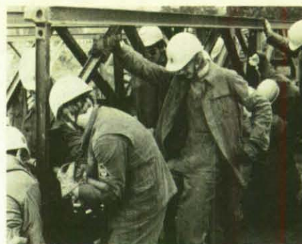
Während der Trägertrupp das Brückenfeld noch mit den Transportstangen festhält, wird das Feld bereits von der Baugruppe verbolzt.
