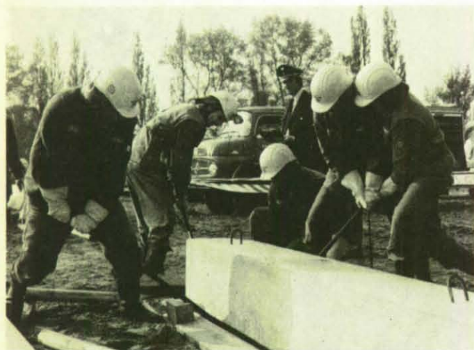
Eine der Aufgaben aus dem Bereich „Bergung“, die Geschick und Kraft erforderte.
