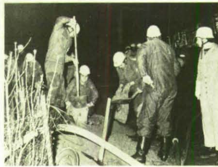
Mit Sandsäcken wurden die Hauseingänge gegen das Hochwasser abgesichert.
