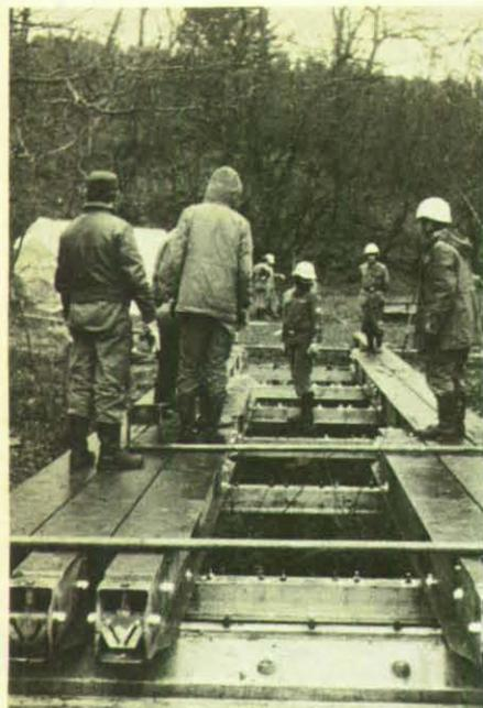
An einem regennassen Wochenende bauten die THW-Helfer eine Grabenbrücke aus LA-Gerät.
