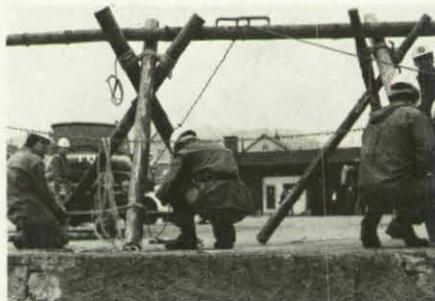
THW-Junghelfer beim Bau eines Portals für eine Seilbahn.
