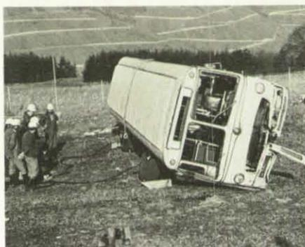
Mit entsprechendem Unterbau kann durchaus ein Omnibus mit Hilfe des Hebekissens aufgerichtet werden.
