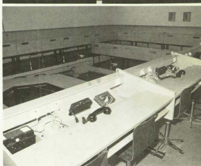
sprechapparat, Antennenanschluß, Steckdose 220 Volt sowie vom Lehrertisch zentral gesteuerte Verriegelung (Diebstahlsicherung). Im Lehrertisch mußten zusätzlich für die Überwachung und Ausbildung der Helfer eine Überwachungstechnik und ein Tonbandgerät sowie der zentrale Verriegelungsmechanismus untergebracht werden.
