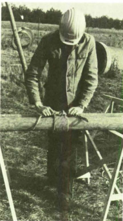
Zu den Prüfungsaufgaben der THW-Helfer gehörte das Zusammenbinden von Rundhölzern ...
