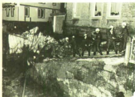
Mit 250 Sandsäcken verhinderten die THW-Helfer das weitere Aushöhlen der Baugrube.
