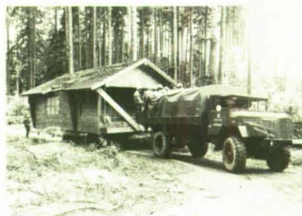
500 Meter wurde das Blockhaus zum neuen Standort gefahren.
