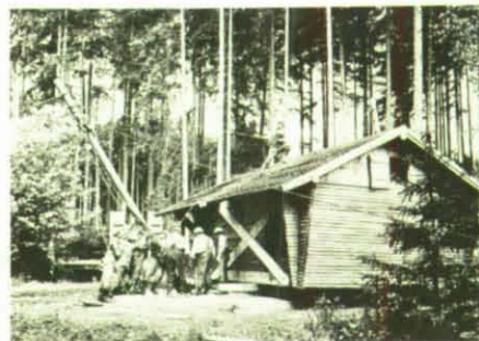
Ein Mastkran steht, der zweite wird aufgestellt.
