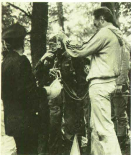
Ausgerüstet mit schwerem Atemschutzgerät, wurde THW-Helfer Heppe in den 35 m tiefen Schacht abgelassen.
