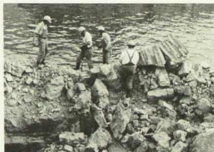
Nach der Sprengung wurde der Trümmerhang nach Versagerladungen abgesucht.
