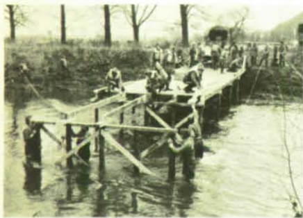
Keine leichte Aufgabe, eine 30 m lange Brücke über die Prims zu bauen.
