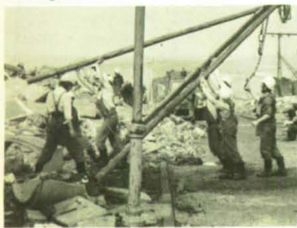
Auch das fachgerechte Erstellen und Aufrichten eines Dreibecks wurde geübt.
