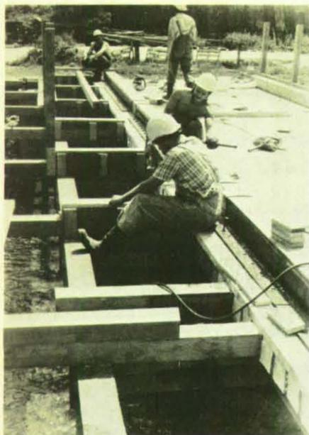
Der Fahrbelag liegt auf, die Rödelbalken werden montiert.
