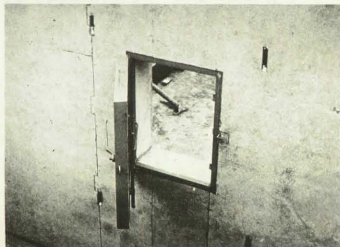
**Bild 5: Paßgenaue Außenwand mit Notausstiegsklappe**
