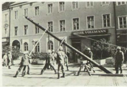
Bei der praktischen Demonstration zeigten die THW-Helfer, wie ein Strommast fachgerecht aufgestellt wird.
