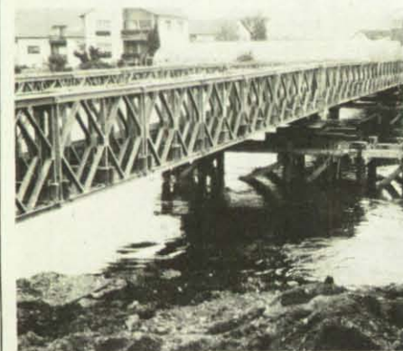
Der Brückenschlag über die Naab ist gelungen.
