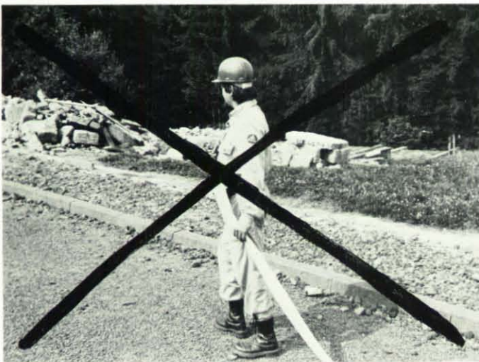
Sicherheitshinweis Nr. 29: Es ist verboten, den Druckschlauch am Körper zu befestigen (BVS-DV III Nr. 4.5.1).
