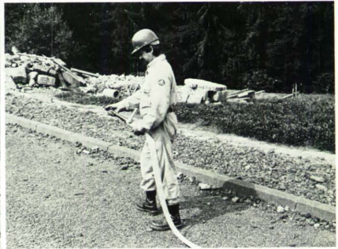
Sicherheitshinweis Nr. 29: Es ist verboten, den Druckschlauch am Körper zu befestigen (BVS-DV III Nr. 4.5.1).
