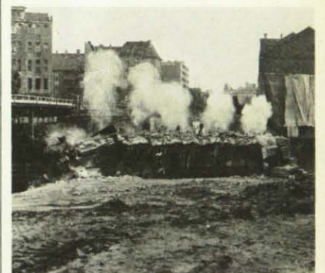
Deutlich ist das Abfließen der Zündstufen von links nach rechts zu erkennen.
