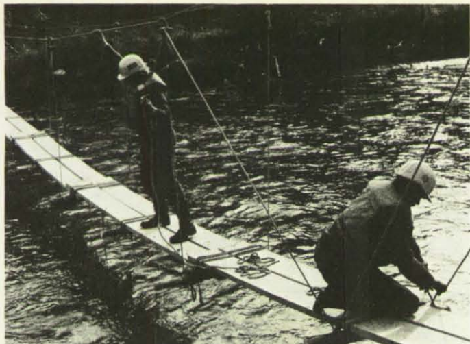
Bau eines Hängesteges über die Agger durch den 3. THW-Bergungszug Bad Honnef.
