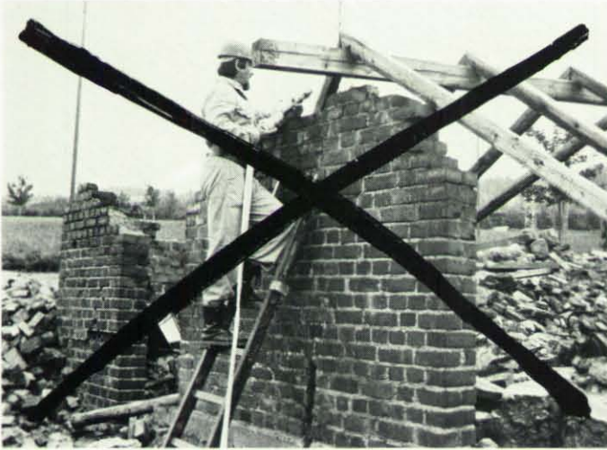
Sicherheitshinweis Nr. 28: Es ist verboten, von einer Leiter aus mit dem Strahlrohr Wasser zu geben (BVS-DV III Nr. 4.5.1).
