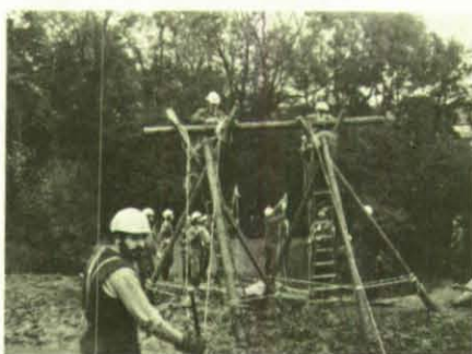
40 Meter lang sollte der Hängesteg werden, den die Berliner THW-Helfer zu bauen hatten.
