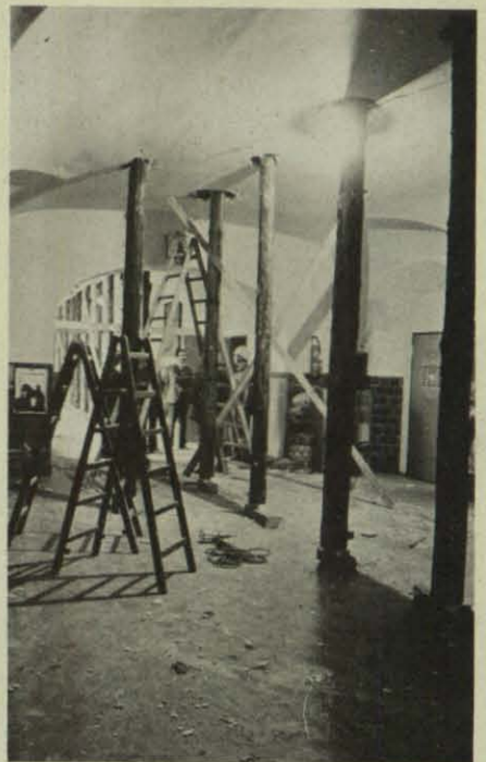
Insgesamt haben die THW-Helfer 220 Stützen eingezogen.
