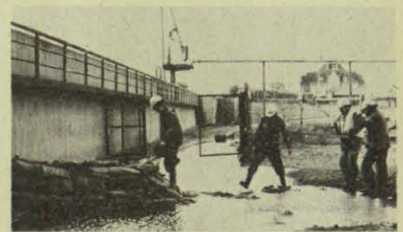
THW-Helfer dichten mit Sandsäcken eine Durchquellung ab.
