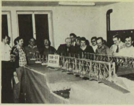
Für die Ausbildung am Standort ist der Modellbausatz einer Bailey-Brücke sehr zweckmäßig.
