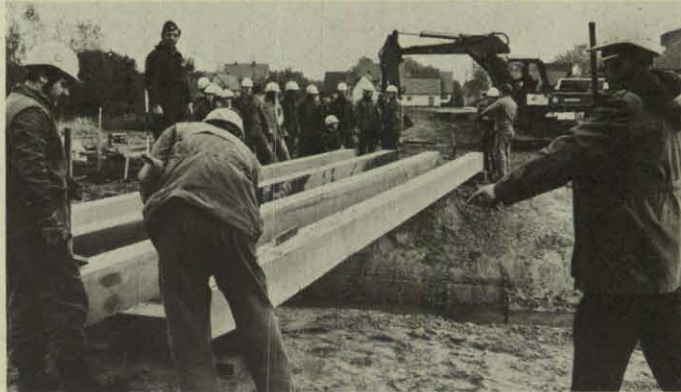
Hohe Anforderungen an Helfer und Gerät stellte der Behelfsbrückenbau aus Bongossiholz.
