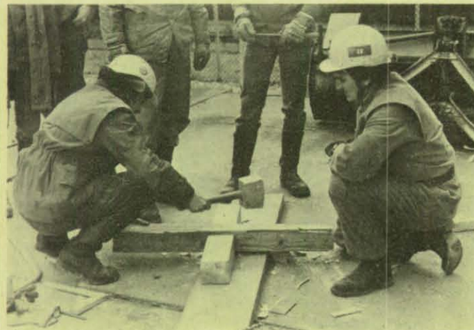
... sowie das Herstellen einer Überplattung.
