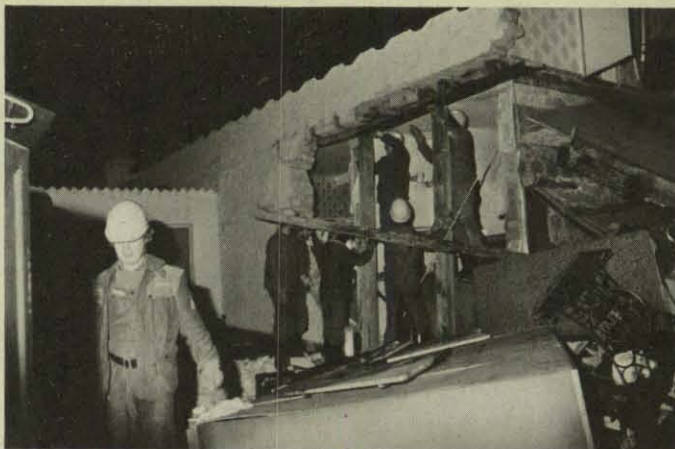
Die Abstützung des Hauses erfolgt u. a. durch Strebstützen.
