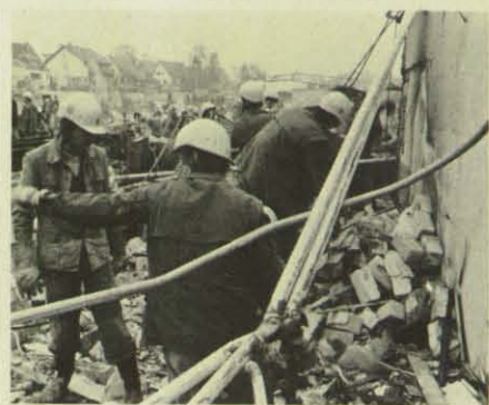
Die THW-Helfer unterstützen die Aufräumarbeiten nach der Explosion.
