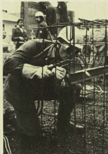
Konzentriert durchtrennt der THW-Helfer eine Eisenschiene mit dem Schweißgerät.
