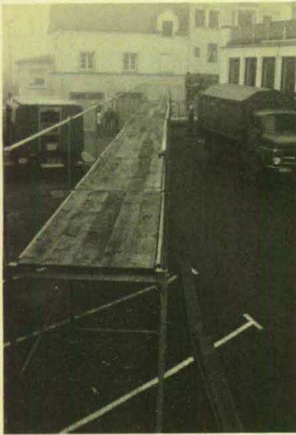
Um mehrere Ecken wurde der Hochwassersteg gebaut.
