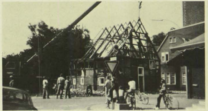
Balken für Balken trugen die THW-Helfer das Fachwerkhaus ab.
