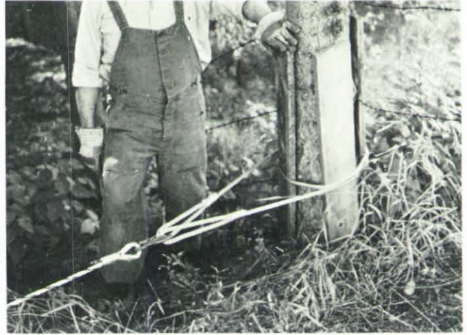
Sicherheitshinweis Nr. 37: Ein direktes Anschlagen des Greifzugseiles an der Last ist verboten (BVS-DV III Nr. 4.4.2.6).
