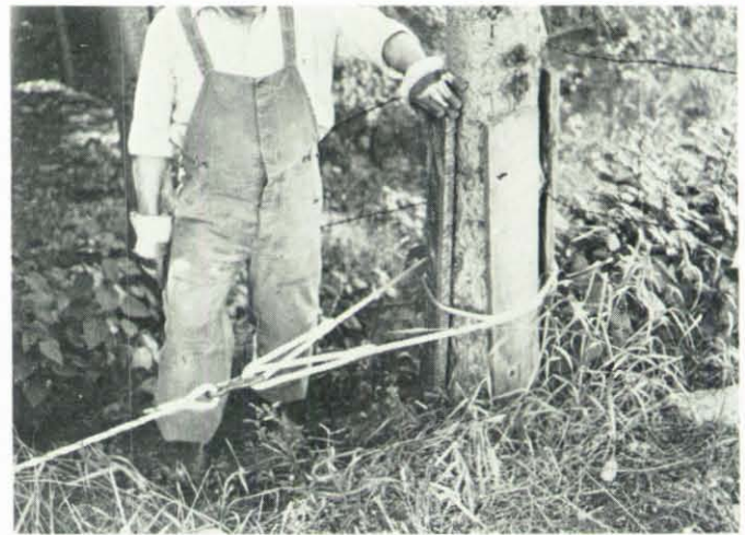
Sicherheitshinweis Nr. 38: Beim Anschlagen einer Last an einen lebenden Baum muß dieser durch Zwischenlagen geschützt werden.
