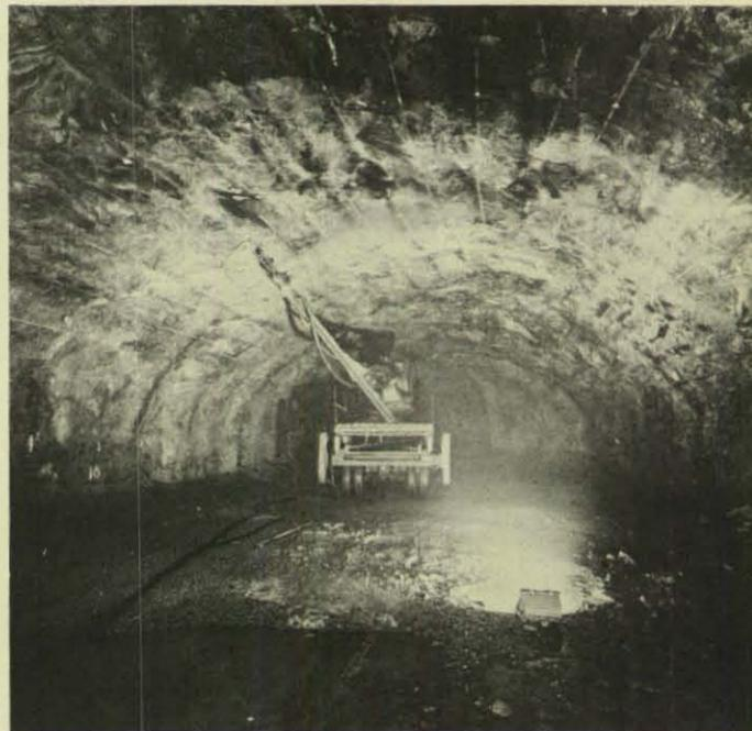
Für die Verlegung von Leitungen werden Bolzen in den massiven Felsen getrieben.
