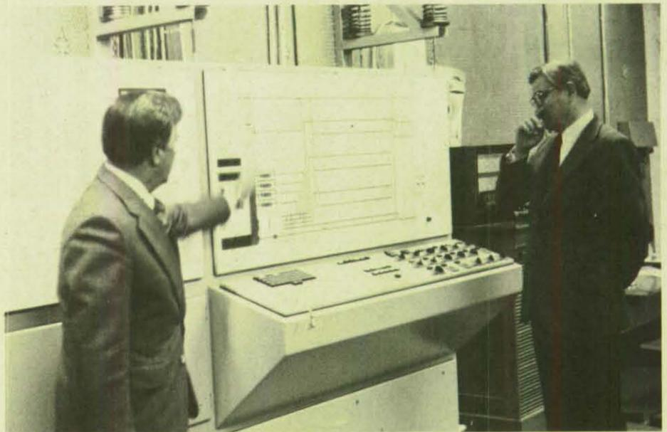
Steuerstand für die technischen Anlagen eines Großschutzraumes, schockisoliert, wie die Federn oben im Bild zeigen.
