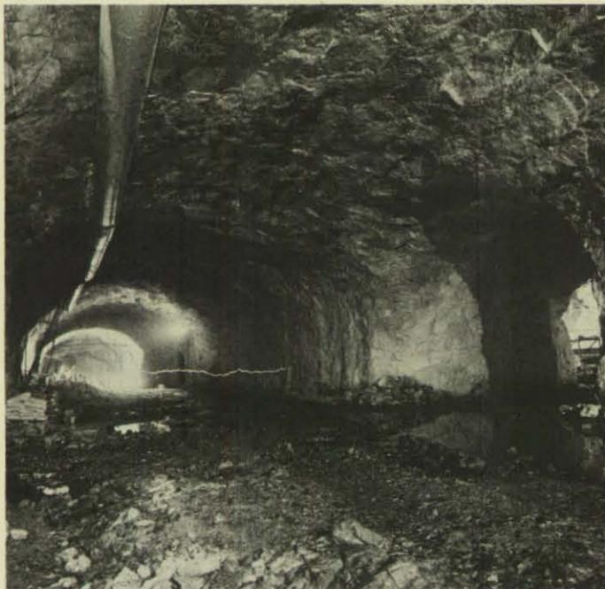
Ein Felsenschutzraum im Bau, die Gesteinsarbeiten sind bereits beendet.
