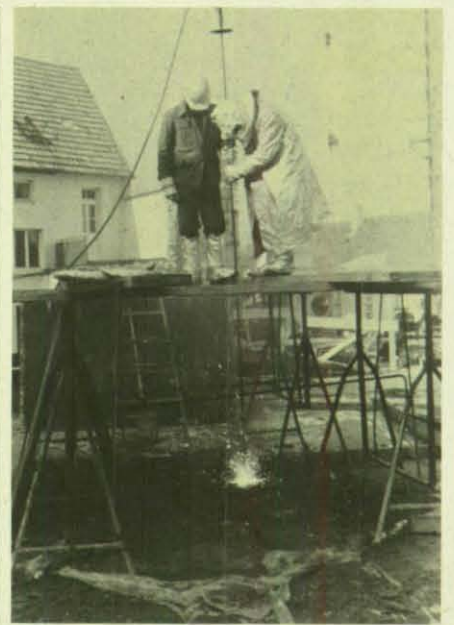
Mit sechs Meter langen Sauerstofflanzen durchtrennen die THW-Helfer die Tresordecke.
