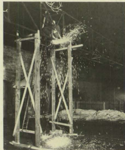
Gute Möglichkeiten zum Üben des „Brennschneidens“ hatten die THW-Helfer beim Abbau dieser Krananlage.
