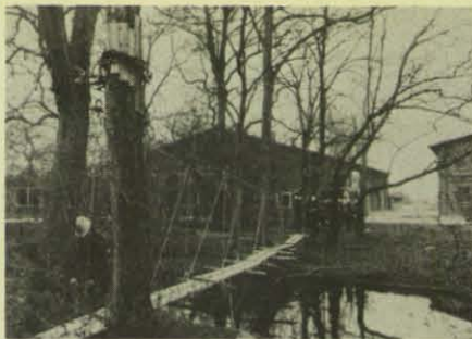
Nur noch wenige Handgriffe und der Hängesteg ist fertig.
