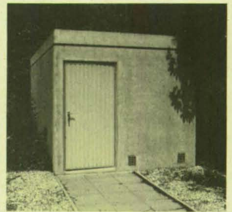
Abb. 9: Oberirdische Übergabestation im Verbundsystem Bielefeld-Ostwestfalen als Stahlbetonfertigteilkonstruktion.
