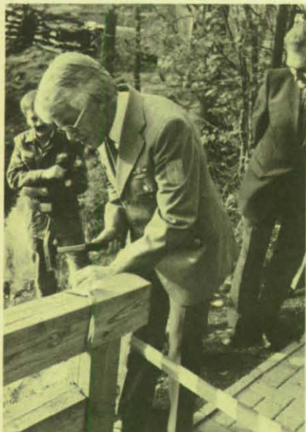
Symbolisch schlägt THW-Kreis- und Ortsbeauftragter Gerhard Hase einen letzten Holznagel in das Geländer der Mühlenbrücke.
