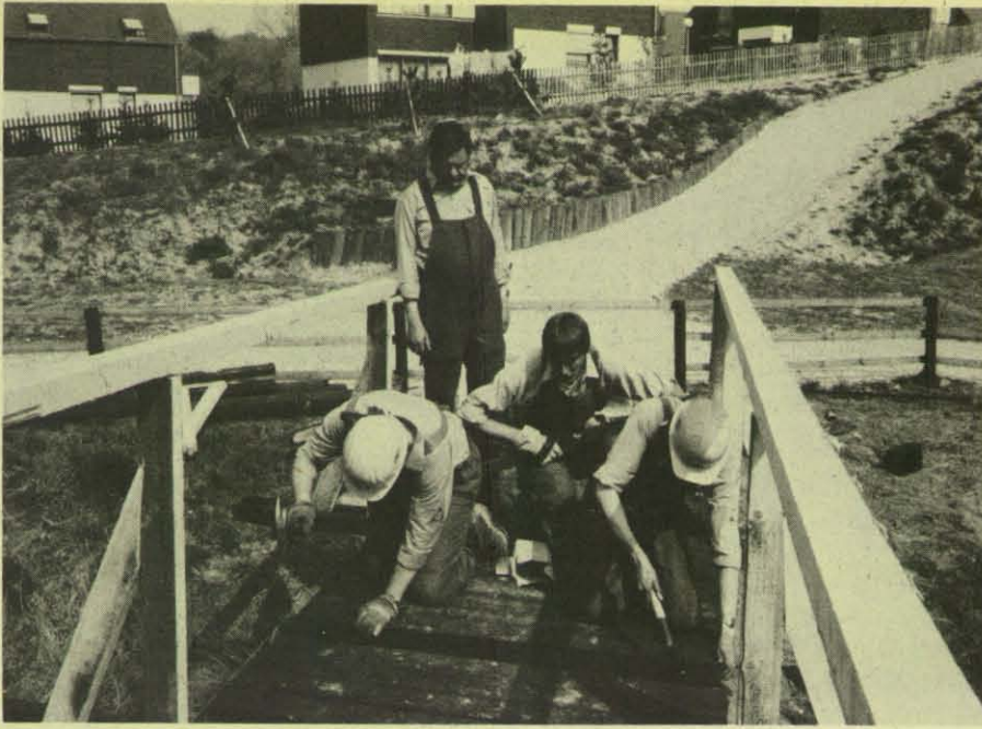
Der Brückenbau steht kurz vor dem Abschluß, nur noch die Gehwegplanken sind anzubringen.
