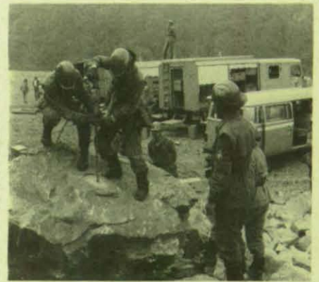
Endlich hatten die THW-Helfer aus Berlin wieder einmal Gelegenheit, Sprengarbeiten durchzuführen.
