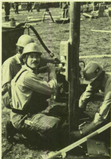
Der Elektro-Trupp baut eine Notstromversorgung auf.
