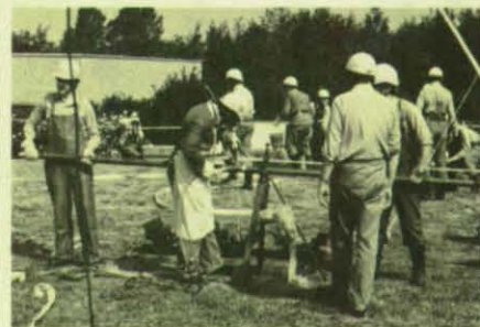
Schweiß- und Gewindeschneidarbeiten sind beim Wasser-Trupp erforderlich.
