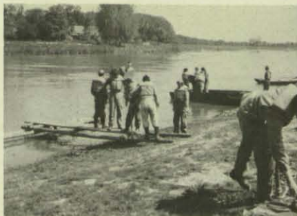
Zu den Übungsaufgaben gehörte auch der Bau eines behelfsmäßigen Anlegers.
