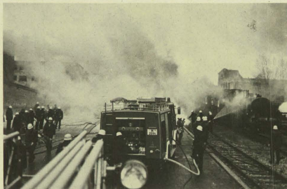
Heftige Brände und starke Verqualmung des gesamten Geländes zeigt diese Aufnahme.
