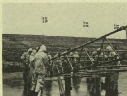
Die THW-Helfer bei der Montage des Zelt-daches.
