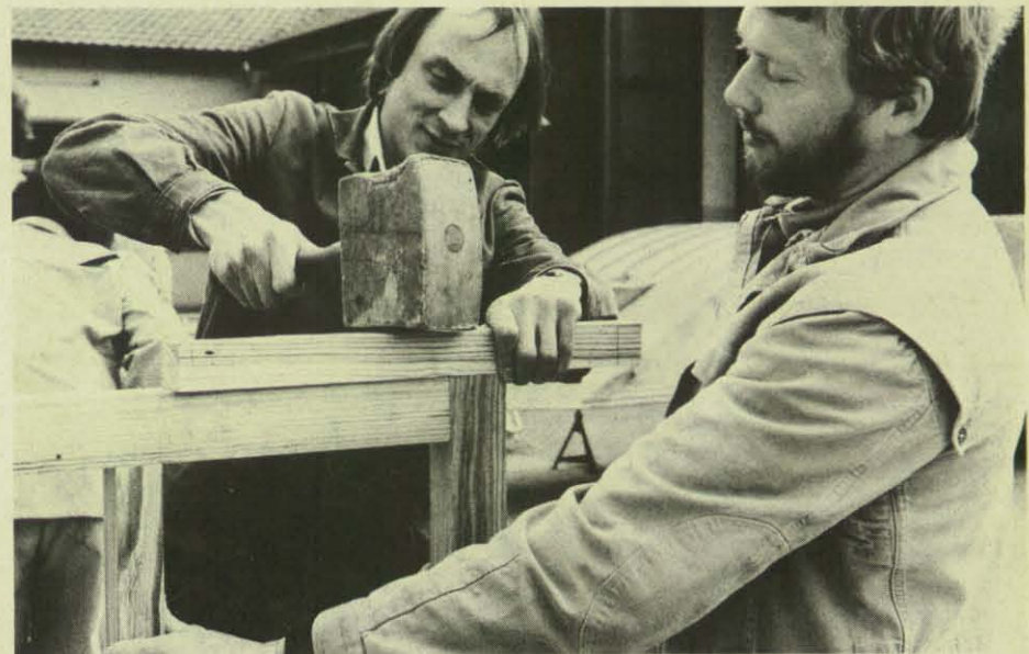
Fachgerecht wird die Fensterrahmenkonstruktion zusammengefügt. Die Helfer arbeiten dabei Hand in Hand.
