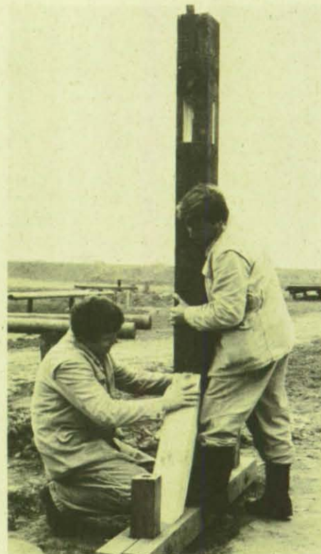
Die Tragkonstruktion für das Walmdach wird aufgestellt und sorgfältig angepaßt.
