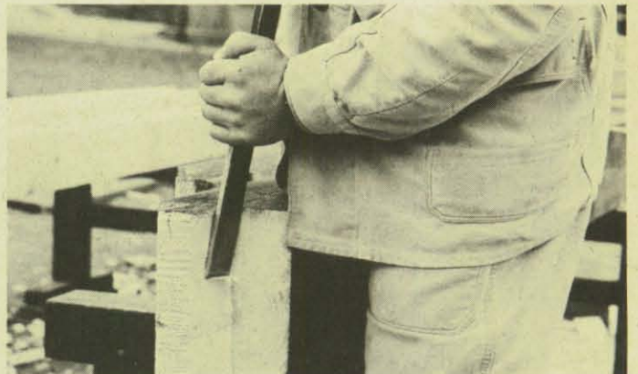
Das Einschlagen der Holznägel erfordert viel Genauigkeit. Dekoratives Aussehen der Verbindung belohnt den Lehrgangsteilnehmer. – Bild rechts: Beim Ausputzen mit der Stoßaxt beginnt man an der Ferse und putzt „mit der Faser“ in Richtung Stirn, so daß die Holzfasern abgeschnitten werden und abbrechen können, ohne zu zerreißen.
