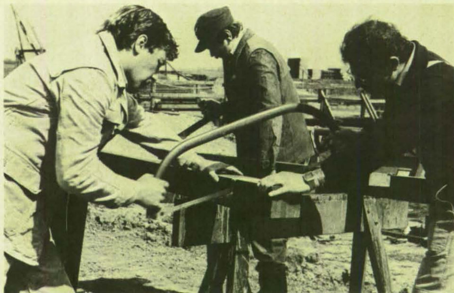
Arbeiten mit der Bügelsäge: Ablängen von besonders hartem afrikanischem Bongossiholz.
