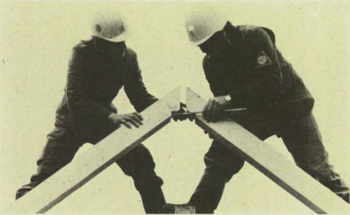
Die ersten Sparren werden angenagelt: Jetzt zeigt es sich, ob die Vorarbeiten präzise ausgeführt wurden. – Bild rechts: Zügig geht die Arbeit voran. Helfer mit Vorkenntnissen in der Holzbearbeitung übernehmen die schwierigsten Aufgaben.
