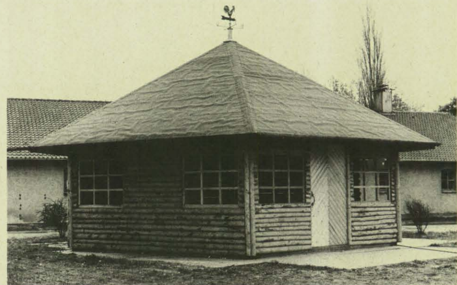
Viele allgemeine Holzverbindungen wurden beim Bau der Behelfsunterkunft im Fünfeck verwirklicht. Mehrere Lehrgänge „Holzbearbeitung“ waren an der Fertigstellung beteiligt.
