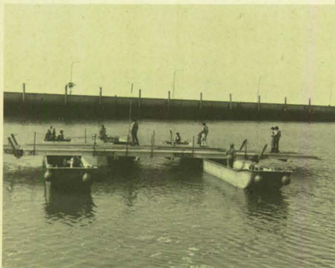
Fahrübungen mit der Fähre im Vorhafen des Eidersperrwerkes.
