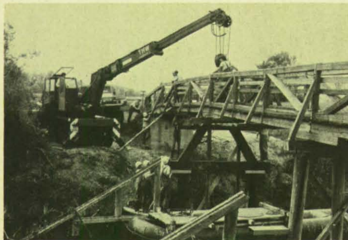
Der THW-Kran hebt den Aufbau des Stegs an, um die neuen Joche einzusetzen.
