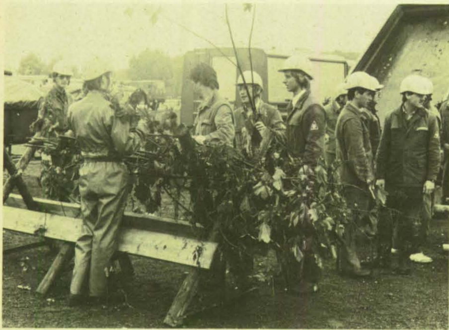
Vor der Öffentlichkeit demonstrieren THW-Helfer den Bau von Faschinen.
