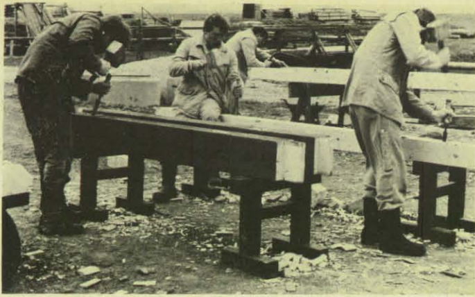
Genauigkeit ist wichtig bei den Stemm- und Sägearbeiten für die Brunnenüberdachung. – Bild rechts: Immer wieder wird der Sitz des Zapfens überprüft. Paßt er nicht, muß nachgearbeitet werden.
