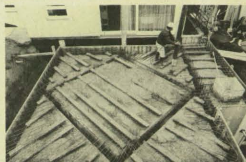
Links: Sämtliche Wandelemente sind eingebracht, die endgültige Gestalt des Schutzraums ist deutlich zu erkennen, ebenso die aussteifende Wirkung der versetzt angeordneten Wände.
