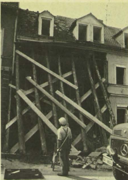
Mit Baumstämmen wird das Dach fachgerecht unterfangen.
