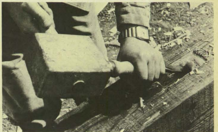
Ein Teil der Konstruktion ist fertig. Für die Aussteifungen wird der relativ einfache Anschluß mit Zapfen ausgeführt. – Bild rechts: Beim Stemmen des Zapfloches muß der Helfer darauf achten, daß das Stemmmeisen immer mit der Holzfaser geführt wird.
