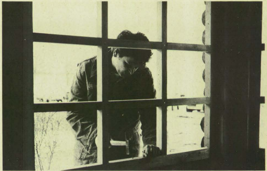
Der letzte Nagel im Fenster gibt sicheren Halt. Nur noch das Glas fehlt.
