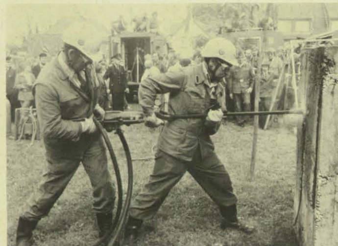
Viele interessierte Zuschauer beim Einsatz des Bohrhammers.
