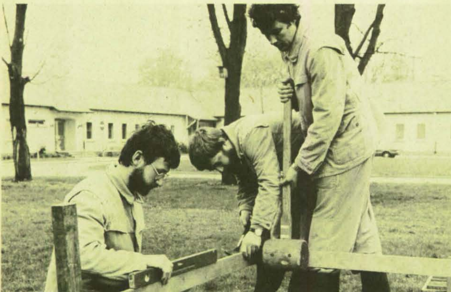
Zum Lehrprogramm gehört auch der Aufbau eines Schnurgerüsts; hier wird der Dielen- oder Bretterkranz in die Waagrechte gebracht.
