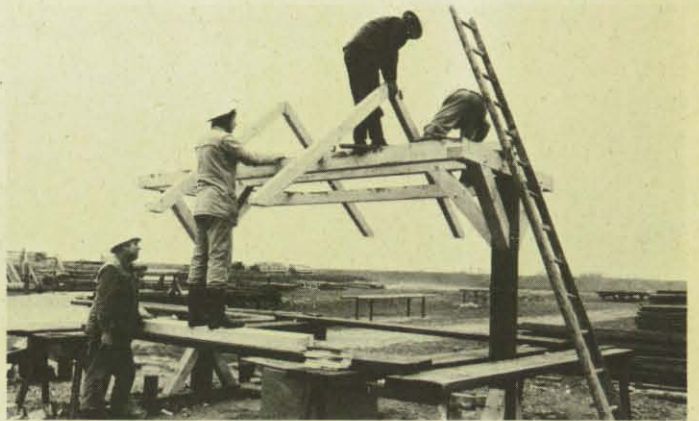
Die ersten Sparren werden angenagelt: Jetzt zeigt es sich, ob die Vorarbeiten präzise ausgeführt wurden. – Bild rechts: Zügig geht die Arbeit voran. Helfer mit Vorkenntnissen in der Holzbearbeitung übernehmen die schwierigsten Aufgaben.
