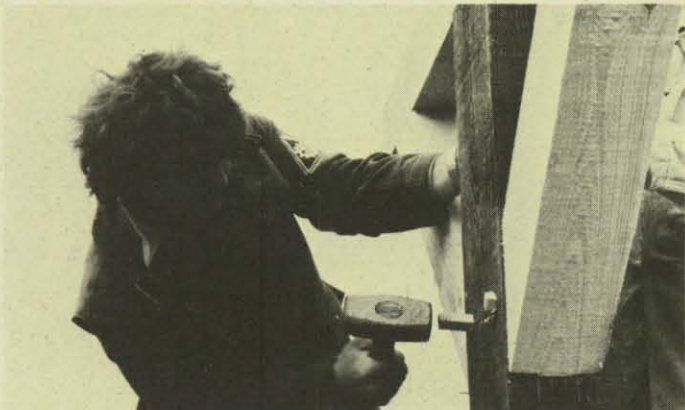
Das Einschlagen der Holznägel erfordert viel Genauigkeit. Dekoratives Aussehen der Verbindung belohnt den Lehrgangsteilnehmer. – Bild rechts: Beim Ausputzen mit der Stoßaxt beginnt man an der Ferse und putzt „mit der Faser“ in Richtung Stirn, so daß die Holzfasern abgeschnitten werden und abbrechen können, ohne zu zerreißen.
