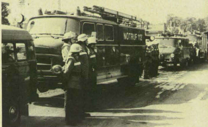
Die Vorstellung eines Löschzuges Wasserversorgung, bestehend aus einem Einsatzleitfahrzeug, zwei Löschgruppenfahrzeugen und einem Schlauchwagen mit insgesamt 25 Mann Besatzung, demonstrierte die Mitarbeit der Feuerwehr im Katastrophenschutz.
