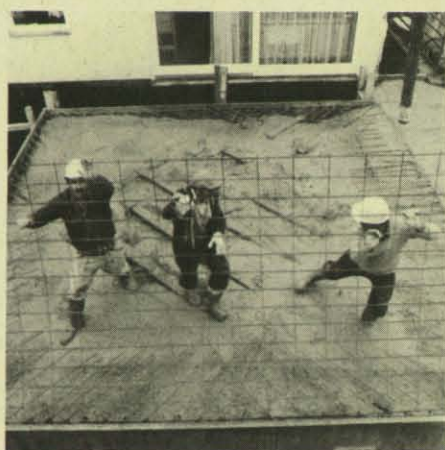
Decke und Wände des Schutzraums werden in einem Zug mit Beton ausgegossen. Als letztes wird die konstruktive Oberbewehrung der Decke eingelegt.
