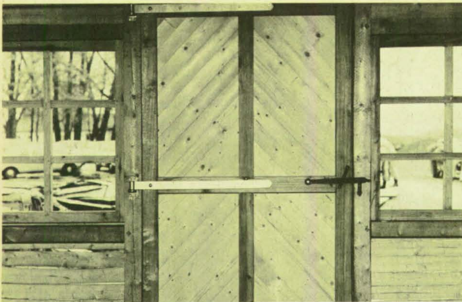
Eine saubere Arbeit. Jeweils eine Gruppe übernimmt die Fertigstellung eines Bauteils.
