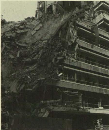
Bild 5: Modernes Wohngebäude in Stahlbetonskelettbauweise mit sehr starken Zerstörungen, nahe dem ehemaligen PLO-Hauptquartier gelegen. Der im Bildvordergrund auf der Straße stehende Wasserbehälter aus Stahlbeton in den Maßen von ca. 6,0 x 2,5 x 2,0 m stand ursprünglich auf dem Dach des Hauses und ist über die eingestürzten Decken abgerutscht. Typisch für die Art der Zerstörungen ist die weitgehende Zertrümmerung der Stahlbetonbauteile des Gebäudes, wie Decken, Gesimsbalken, Stützen usw.
