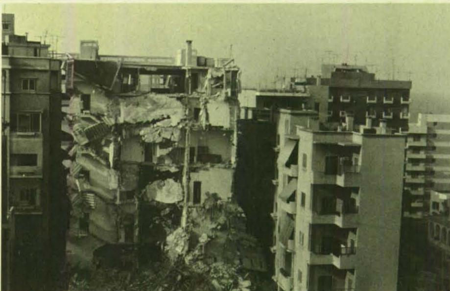
**Bild 6:** Modernes Wohngebäude mit starken Zerstörungen. Auch hier wird wieder die weitgehende Zertrümmerung der Stahlbetonteile (Decken, Wände, Treppen und -podeste usw.) deutlich.
