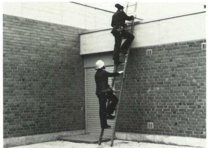
Die Standsicherheit und Tragfähigkeit von Leitern wird insbesondere dann nicht beeinträchtigt, wenn . . . Haken-, Steck-, Klapp- oder Anstelleitern und Teile von mehrteiligen Leitern nur von einer Person bestiegen werden. (D zu § 20)
