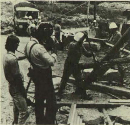
Kameraeinstellung über die Verwendung des Greifzuges beim Anheben schwerer Lasten mit Hilfe des Zweibocks.
