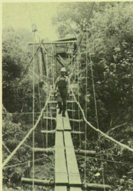
Erste Belastungsprobe für den Seilhängesteg.
