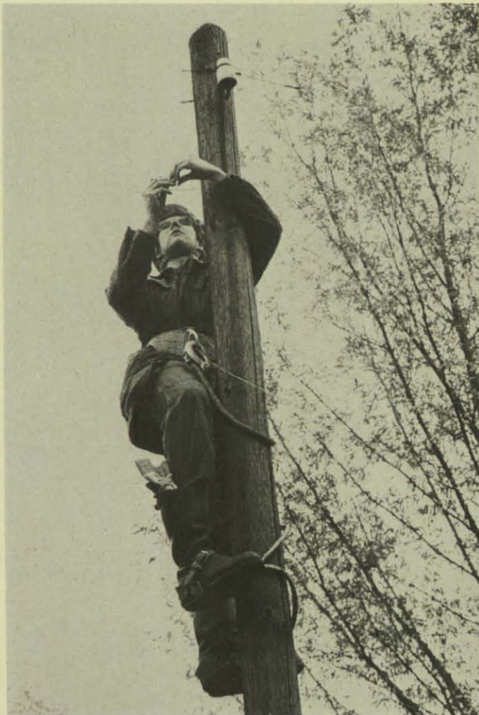
Bild links: In luftiger Höhe will der Anschluß von Freileitungsklemmen gelernt sein. – Bild rechts: Ölfilm auf einem Gewässerlauf: Helfer des THW stellen die Verschmutzung unter einer Brücke fest.
