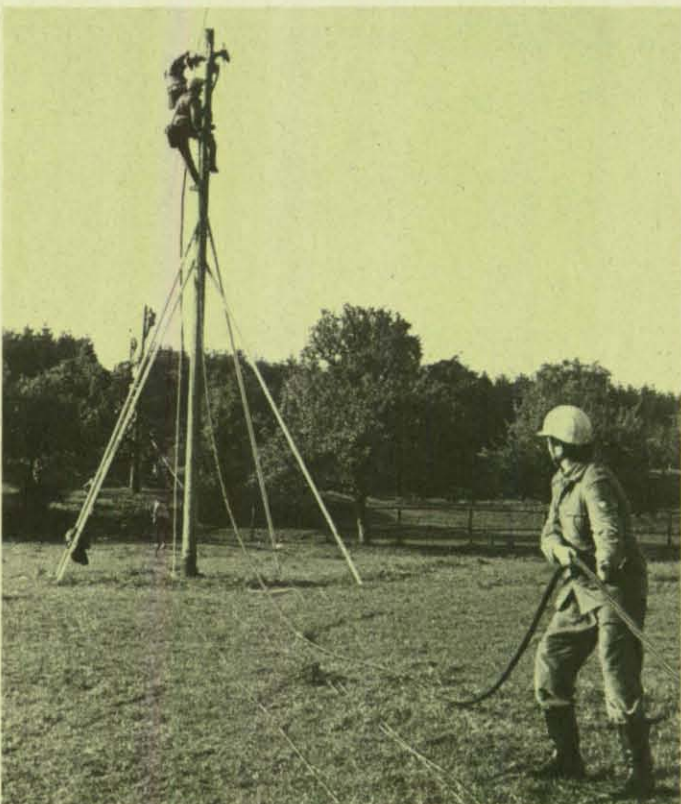
Ein gutes Übungsobjekt für die THW-Helfer: Umbau einer Freileitung. (Foto: Kugelart)
