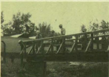
Nur einen Tag brauchten die THW-Helfer für den Bau des Fußgängerstegs. (Foto: Leipold)
