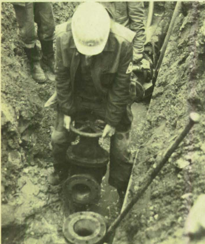
Einsetzen eines Schiebers.
