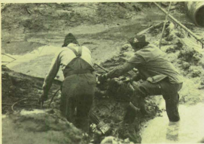
Abwasser, Brauchwasser und Trinkwasser flossen in diesem Bombenrichter vor dem Lager Sabra zusammen; einen Tag vor dem Heimflug konnte das THW auch diese Baustelle abschließen.
