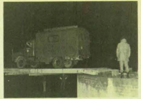
Mit einem MKW wird die Belastungsprobe durchgeführt. (Foto: Hagen)
