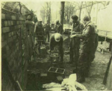
Das Schwergewicht der Ausbildung lag auf dem praktischen Teil, hier die Helfer beim Verfüllen der Baugrube nach Abschluß der Reparaturarbeiten. (Foto: Brühl)
