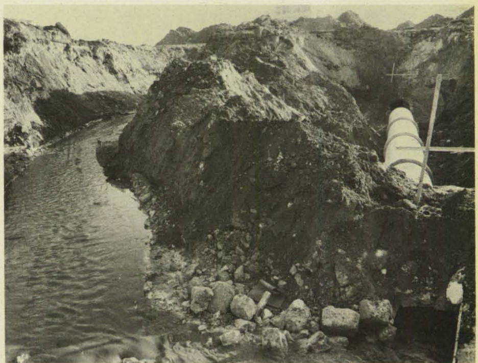
Die Baustelle Spinners I, hier wurde ein zerstörter Abwasserkanal neu verlegt.
