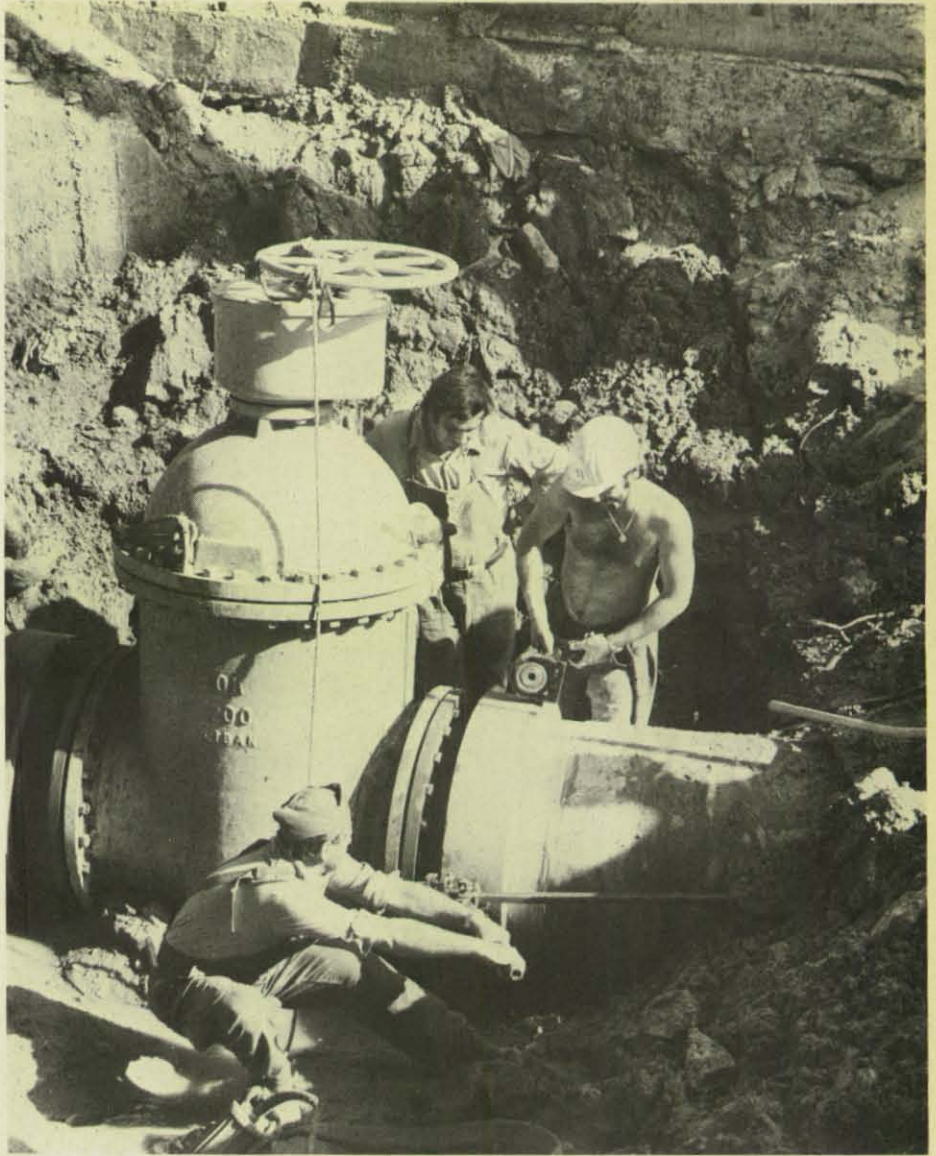
Von der UNICEF finanziert, vom THW an die 700er Leitung gekuppelt: Montage des Schiebers bei brütender Hitze.
