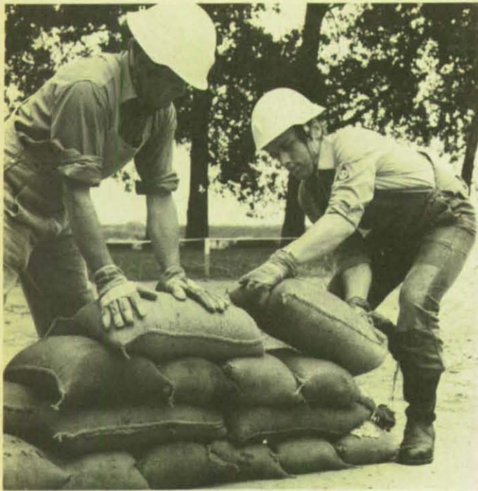
Das Verlegen von Sandsäcken ist Bestandteil der Ausbildung im Teilgebiet 9 und als Prüfungsaufgabe der Zwischenprüfung zu lösen.
