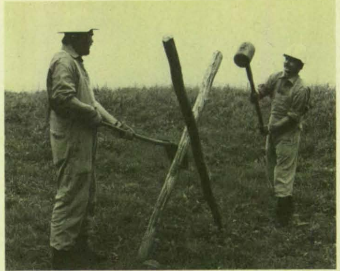
Beim Herstellen von Teilen eines Faschinenbank-Pfahlbockes wird neben der fachlichen Ausführung besonderes Gewicht der Unfallverhütung beigemessen.
