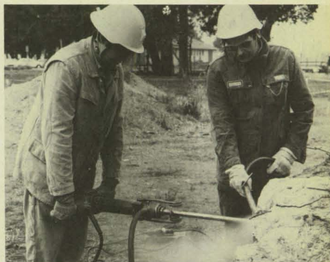
Zwei Lehrgangsteilnehmer demonstrieren das Bohren mit dem Gesteinsbohrhammer in waagerechter Richtung. Beide Helfer haben Schutzbrille und Schutzhandschuhe zu tragen.
