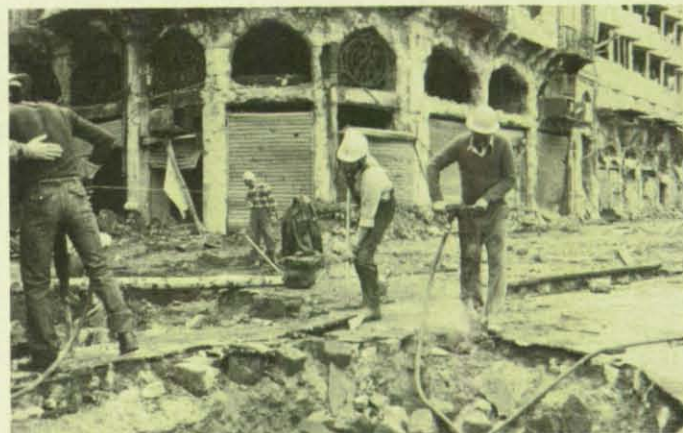
Die Suche und Freilegung der Wasserleitungen in der zerstörten Innenstadt erforderte oftmals schwerste Handarbeit.
