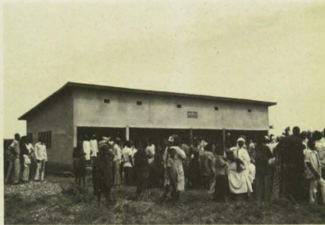
Medico-Sozial-Station Madjatom, kurz vor Beendigung der Bauarbeiten.
