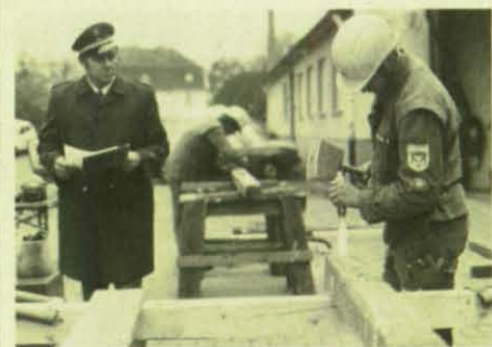
Ein prüfender Blick: Werden die Stemmarbeiten fachgerecht ausgeführt?
