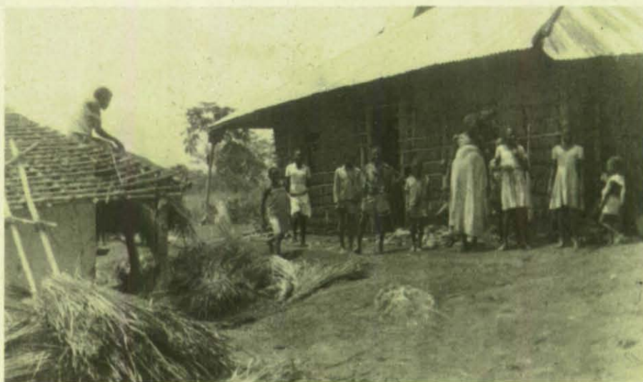
Handwerker setzen eine Gesundheitsstation in stand – finanziert werden die Arbeiten vom DRK.
