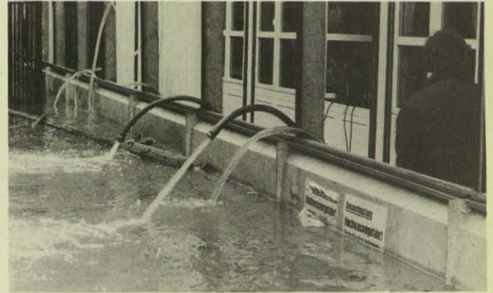
Schutzwände waren rechtzeitig angebracht worden. Dennoch mußte Grundwasser aus den Häusern gepumpt werden.
