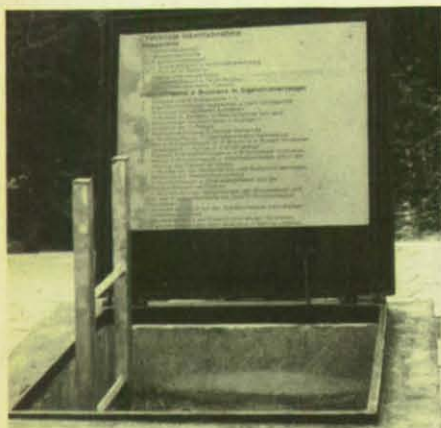
Bild 2a und b: Brunnenschacht beim Prototyp des neuen Trinkwasser-Notbrunnens mit aufgeklappter bzw. geschlossener Schachtabdeckung (auf der Innenseite befestigte Hinweistafel ähnlich Bild 6), Steigleiter mit aufgeklappter Einstieghilfe bei geöffneter Schachtabdeckung.
