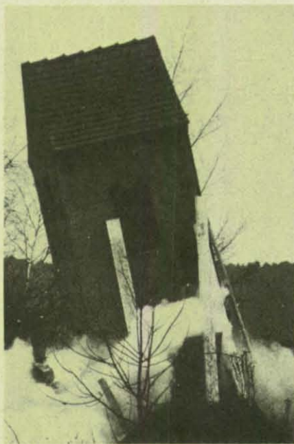
Das Trafohäuschen im Augenblick der Sprengung. (Foto: Schneeberger)
