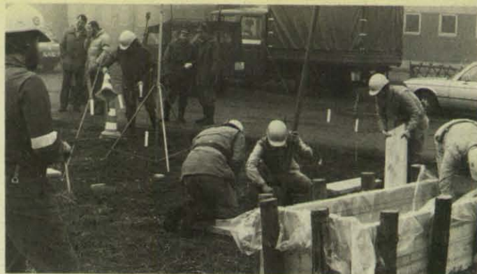
THW-Helfer beim Bau eines Wassernetbehälters. (Foto: Walser)
