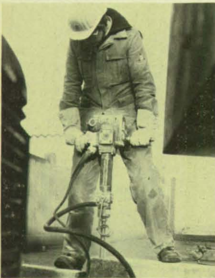
Auch der Gesteinsbohrhammer muß fachkundig bedient werden. (Fotos: Vollrath)
