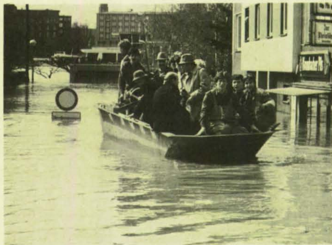
THW-Helfer transportieren mit Pontons Anwohner zu ihren Häusern. (Foto: Schmitz)
