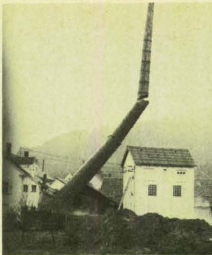
Zentimetergenau wird der Kamin in eine schmale Gasse gelegt. (Foto: Schneeberger)
