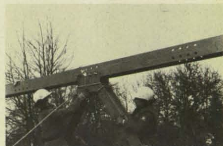
Wieder aufgenommen: die Ausbildung an der 40-Tonnen-D-Brücke. (Foto: Krüger)
