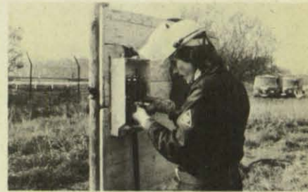
Helfer einer Elektrogruppe bei Vorbereitungsarbeiten zum Aufschalten eines Erdkabels zu einer Freileitung.
