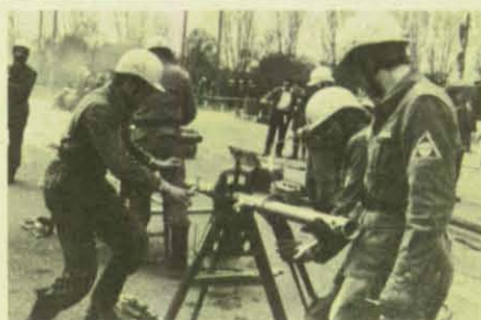
Unten: Mit zu den Aufgaben gehörte die Erstellung einer Trinkwasserversorgung. (Fotos: Delle)
