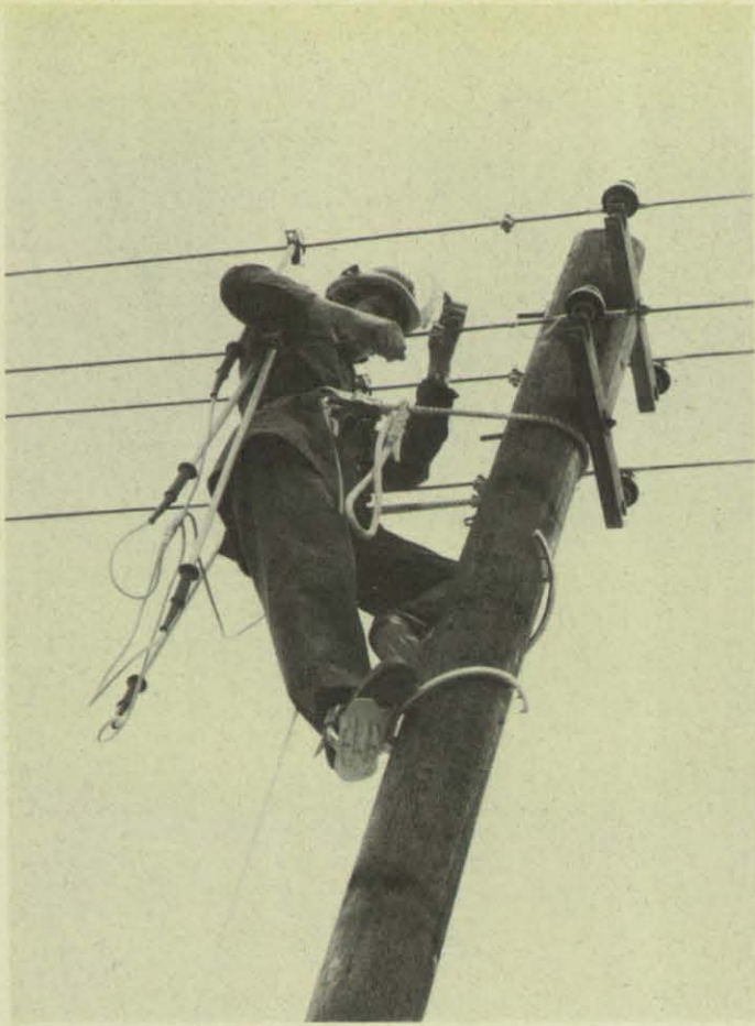
Bild links: Beim Wettkampf des I-Dienstes: Hier wird an einer Freileitung 0,4 kV unter Einhaltung der Sicherheitsvorschriften gearbeitet. Die Leitung ist freigeschaltet, geerdet und kurzgeschlossen. Ein Kabelanschluß wird vorbereitet. Bild rechts: Gewindeschneiden an einem Stahlrohr 1".
