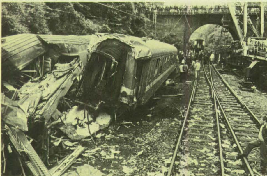
Die Bundesbahn setzte einen Großkranwagen für die Aufräumarbeiten ein. Links die zerstörten Waggon, die fünf Tage später in Brand gerieten.
