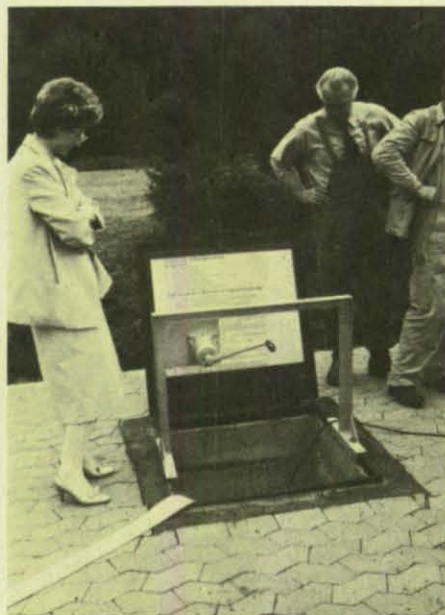
Bild 8b: Trinkwasser-Notbrunnen, ausgerüstet mit einer vom öffentlichen Stromnetz unabhängigen elektrischen Unterwassermotorpumpe und im Brunnenschacht eingelagerten Ausstattungsteilen, wie transportabler Eigenstromerzeuger, Druckschläuche zur Trinkwasserförderung, Unterwasserkabel, Handseilwinde mit Gestell, Gruppenzapfstelle zur Wasserverteilung an die notzuversorgende Bevölkerung (Schnittzeichnungen).
