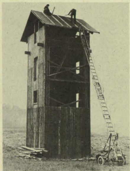
Der THW-Übungsturm wird wieder instand gesetzt. (Foto: Reile)
