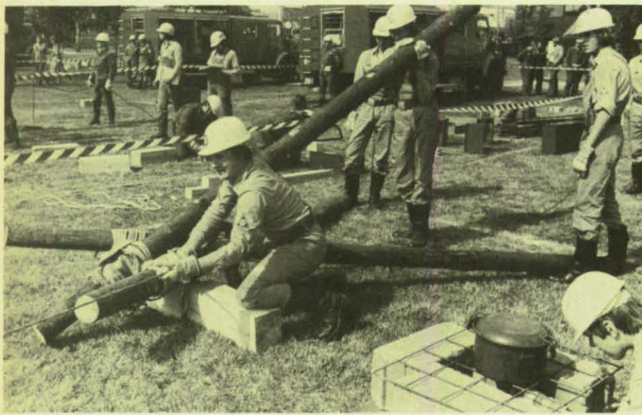
Junghelfer des THW beim Kreuzen von Dreibockbeinen.
