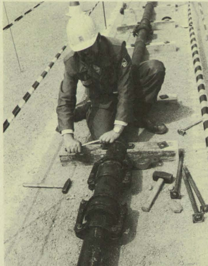
Bild links: Eine Wasserversorgungsleitung DN 100 wird vor der Druckprobe auf einer Holzunterlage mit Schellen befestigt (diese Anordnung erfolgte nur im Rahmen der Übung). Im Vordergrund ein U-Stück mit zwei ARS-Rillenschellen längskraftschlüssig gemacht. Bild rechts: Eine Abwasserkanalleitung DN 600 ist behelfsmäßig instand gesetzt. Ein zerstörtes Rohr wurde durch eine Holzrinne, mit Dachpappe ausgeschlagen, ersetzt. Der Übergang zum Betonrohr wird mit Faserspachtelmasse abgedichtet.
