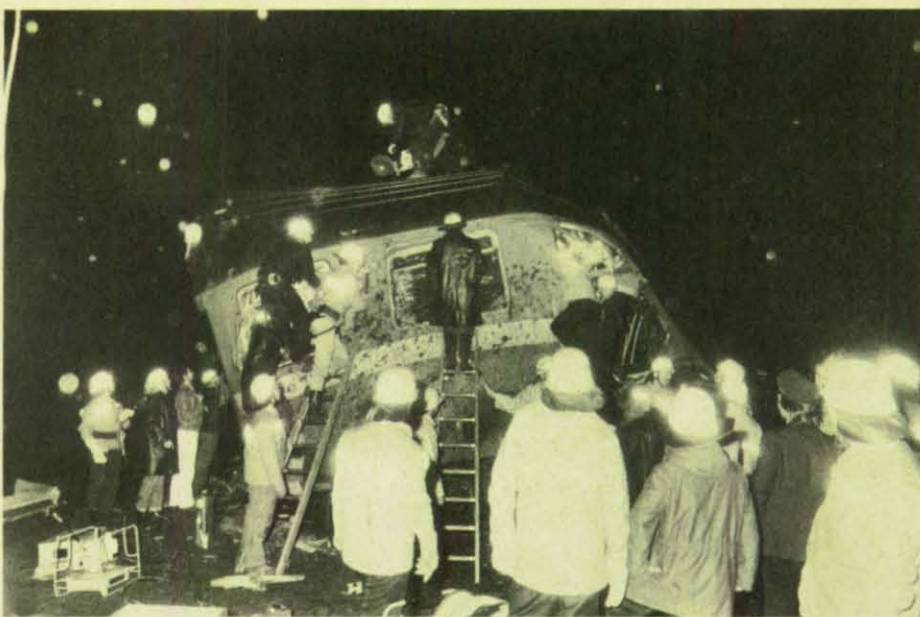
Mit Trennschleifern wird die Außenhaut der Waggons aufgeschnitten.
