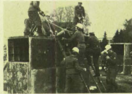
Zügig geht der Rücktransport vor sich.
