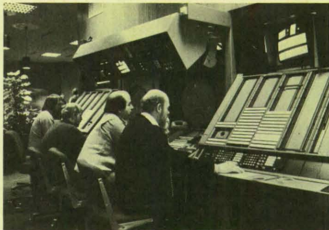
Arbeitsplatz mit Radarsichtgerät in der Bezirkskontrolle (Streckenkontrolle) der FS-Regionalstelle Frankfurt.
