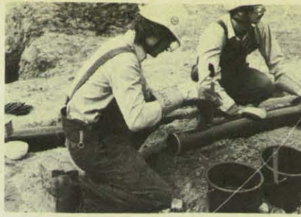
Helfer der AÖ-Gruppe richten eine Abwasserleitung aus Steinzeug her.
