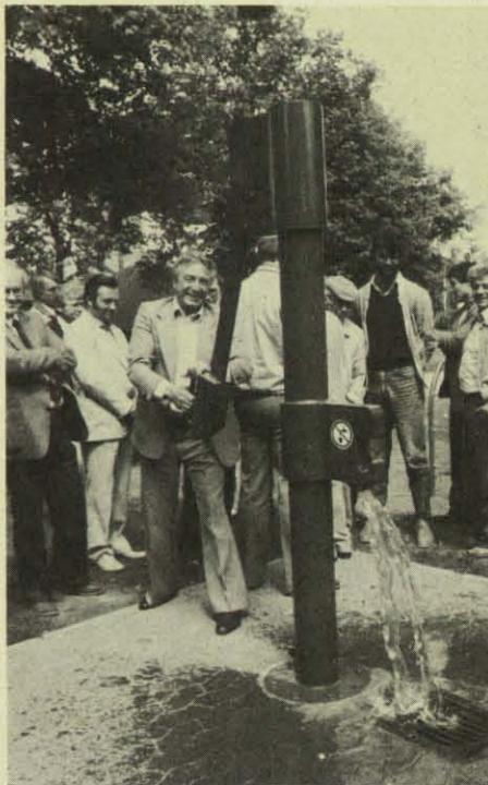
Bild 5: Berliner Straßenbrunnen (Handständerpumpe) mit Frosthahneinrichtung und Bodenablauf für Überschußwasser.
