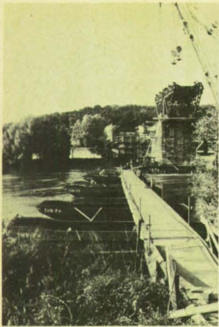
Die Stegverbindung zur Brückenbaustelle. (Foto: Blöchl)
