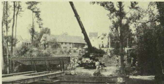
Die 35 Meter lange Brücke hat eine maximale Tragfähigkeit von acht Tonnen und wurde innerhalb von sechs Stunden mit dem SD-Gerät geschlagen. Zum Einsatz kam dabei auch der neue Kranwagen des Ortsverbandes.
