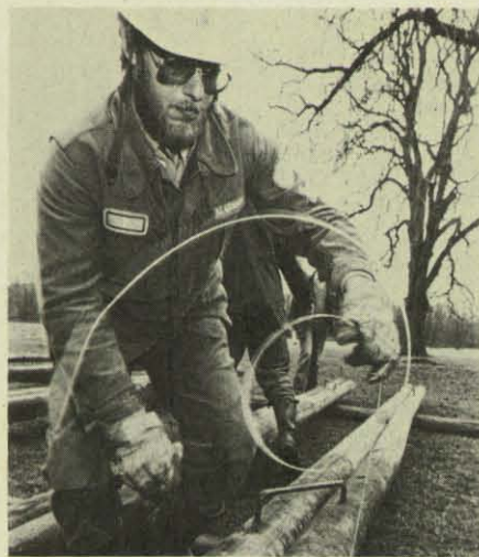
Die benötigten Masten werden von den THW-Helfern zusammengebaut. (Foto: Busler)
