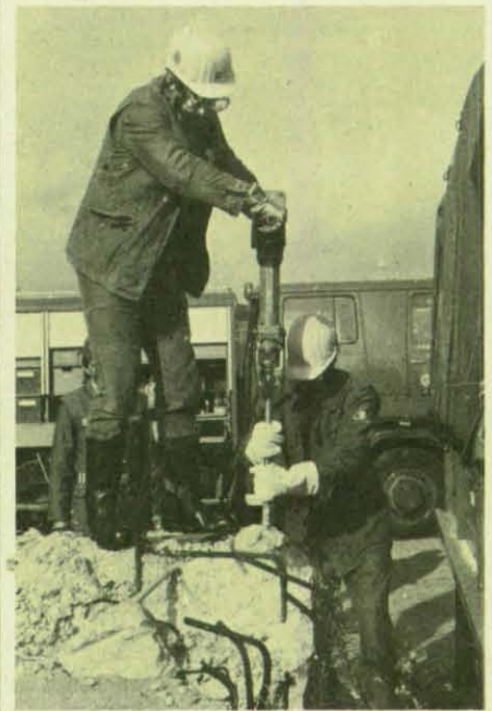
Eine der Aufgaben der Prüfung ist das Arbeiten mit dem Gesteinsbohrhammer. (Foto: Reiz)
