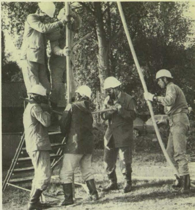
bar das Wasser am unteren Ende der Lanze aus und spült den Boden auf. Stetig heben und senken die Helfer die Spüllanze, eine wichtige Arbeit, denn die Lanze darf keinesfalls in den Boden geschlagen, gepreßt oder gebohrt werden, da hierdurch der Spülwasseraustritt verstopft und die Lanze beschädigt werden kann.
