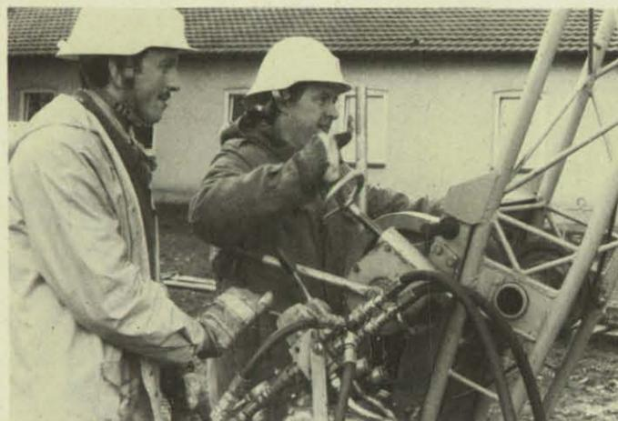
Knifflig ist die Bedienung des Öltriebsaggregats. Die Helfer werden vorher in die Handhabung eingewiesen.
