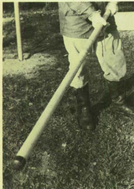
Der ein Meter lange Kunststofffilter ist mit den Aufsatzrohren zusammengeschaubt.
