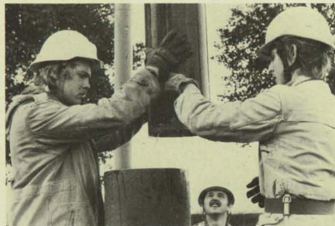
Der Stauchbohrer kommt hoch, gefüllt mit Bohrgut und Wasser. Der Vorgang wiederholt sich stetig, bis die Grundwasserleiterschicht erreicht ist.
