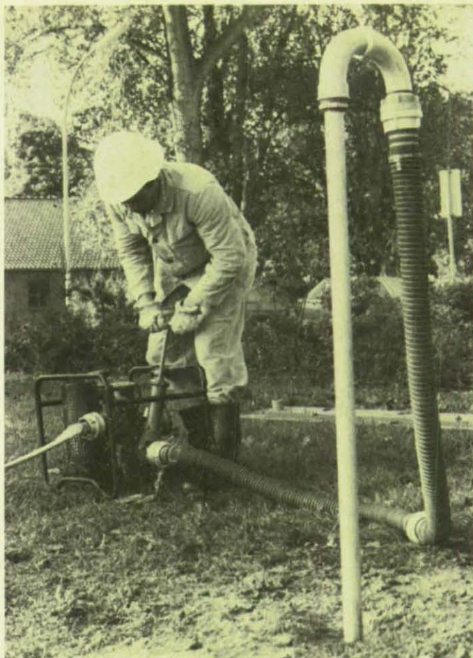
benpumpen (Schwengelpumpen) angeschlossen werden. Die Förderkapazität des Spülbrunnens liegt bei rund anderthalb Kubikmeter Wasser in der Stunde. Wenn mehr Wasser benötigt wird, können weitere Spülbrunnen erstellt und dann parallel verbunden werden.
