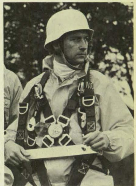
**Das neue Rettungssystem, das Klaus Hanft entwickelte, besteht aus der Abwandlung eines Fallschirmspringergurtes, an dem Haltevorrichtungen für das Anbringen einer Halteschleife für zu rettende Personen angebracht wurden.**
