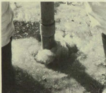
Gut auf dem Bild zu erkennen ist das Einspülen der Lanze. Das Erdreich wird mit Wasser vermisch seitlich herausgespült.
